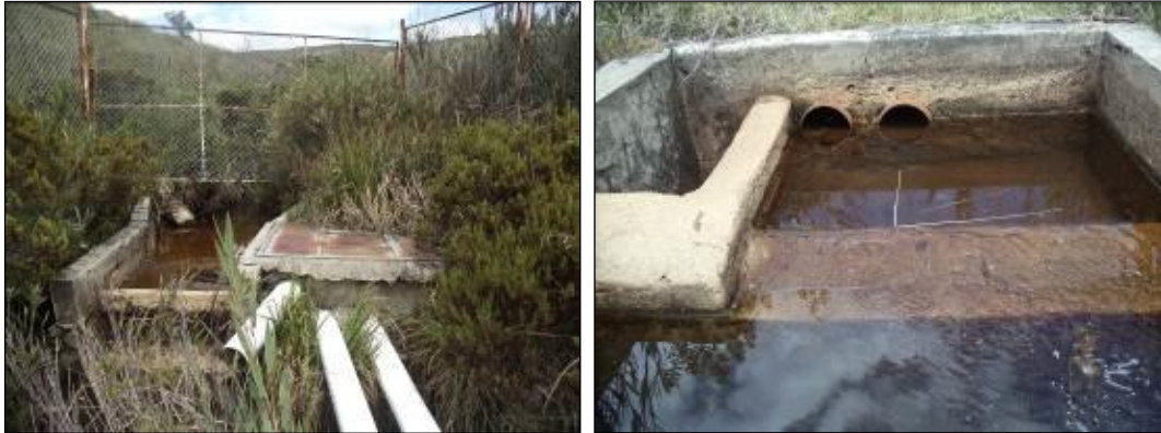
Fuente: Captación bocatoma de fondo Páramo los Curies
