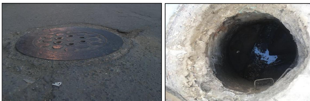
pozo de inspección.
