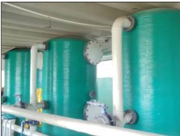
Filtros rápidos, PTAP Vivero Macromedidor, PTAP Vivero
