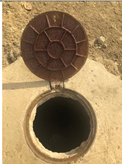
Imagen 40 y 41 Pozo de inspección vía Laguna de Oxidación
