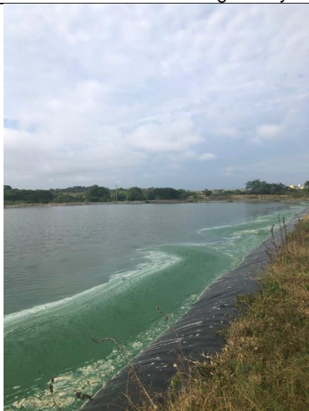
Imagen 50 y 51 laguna de oxidación
