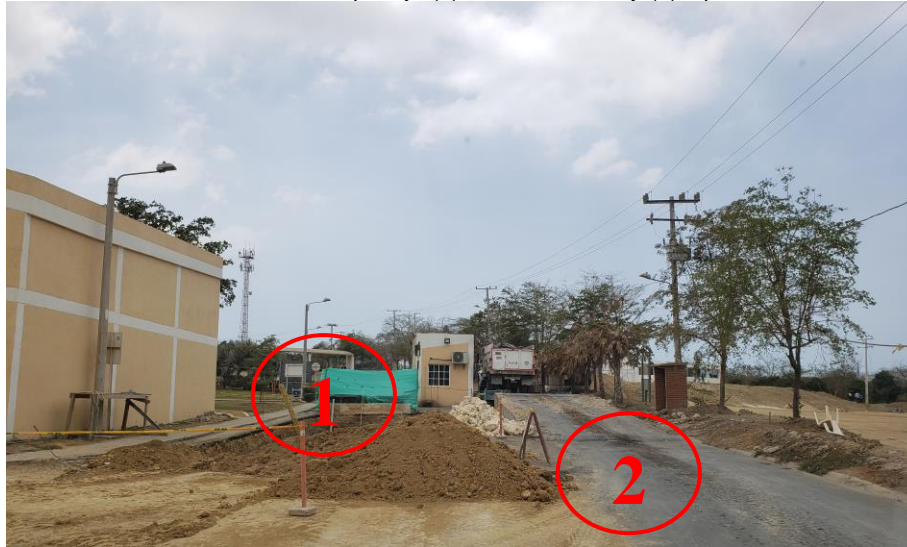
Foto 4. Básculas de pesaje (1) Mantenimiento y (2) Operativa
