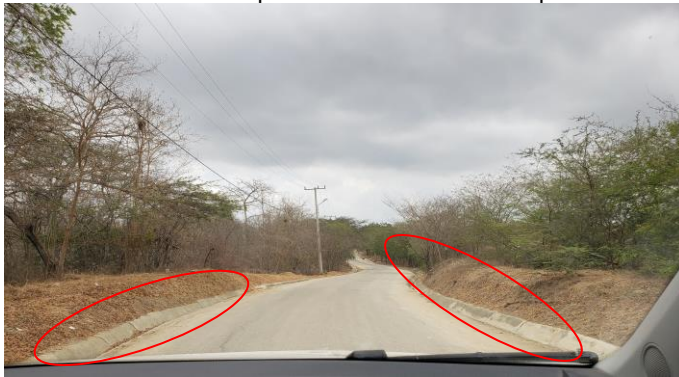
Foto 16. Canales perimetrales vías internas parte 1.
