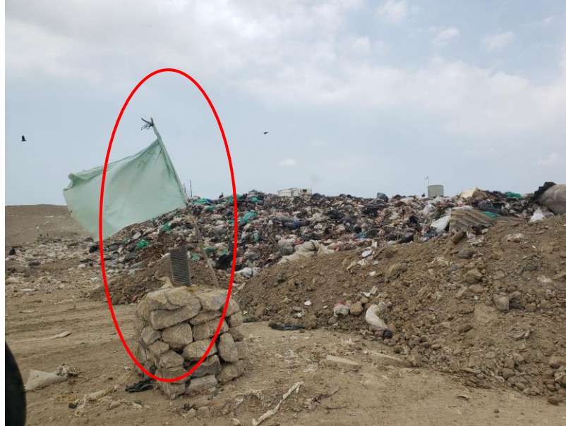
Foto 12. Chimenea frente de trabajo
