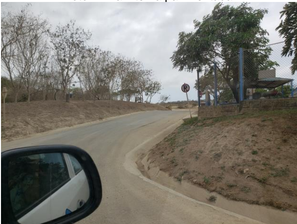
Foto 2. Vía interna pavimentada.
