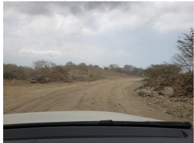
Foto 3. Vía interna en afirmado.
