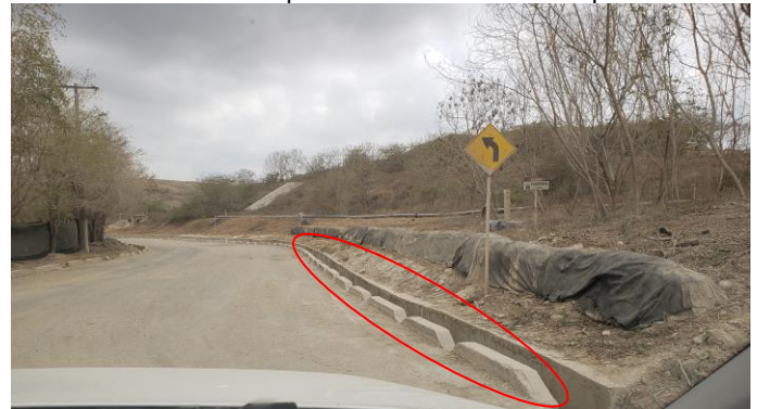
Foto 17. Canales perimetrales vías internas parte 2.
