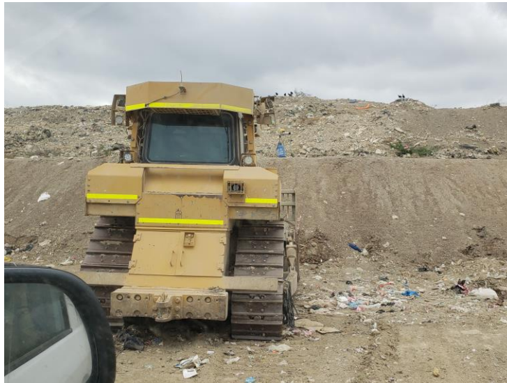
Foto 7. Buldócer realizando labores
