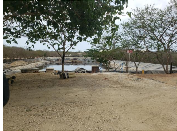
Foto 14. Piscina de almacenamiento
