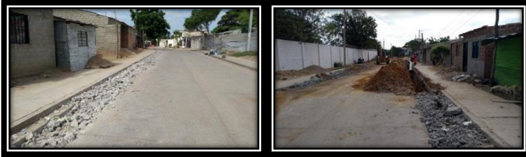
Corte y demolición de pavimento
