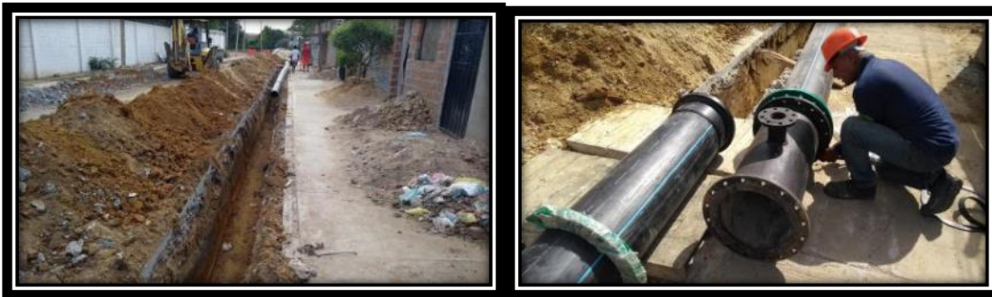
Instalación de tubería Pead 14"
