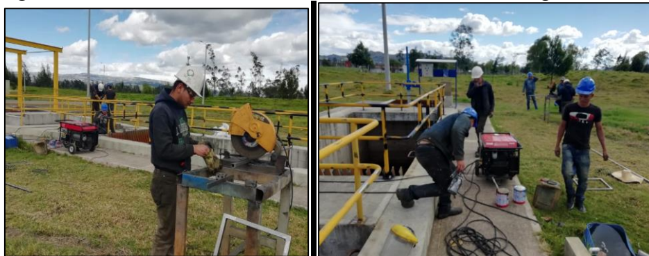
Fotografía 7-8. Mantenimiento estación de bombeo de aguas residuales
