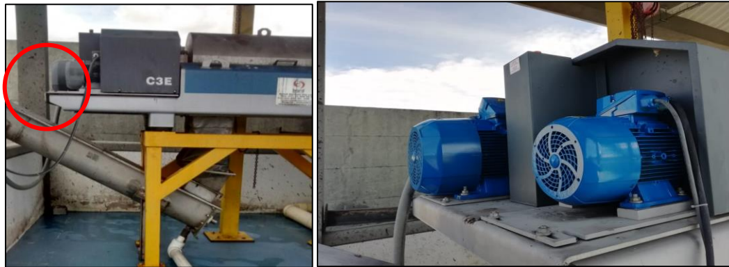
Fotografía 15-16. Estado inicial y final motores centrífuga de lodos
