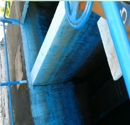
Fuente, tomada desde los lechos filtrantes.
