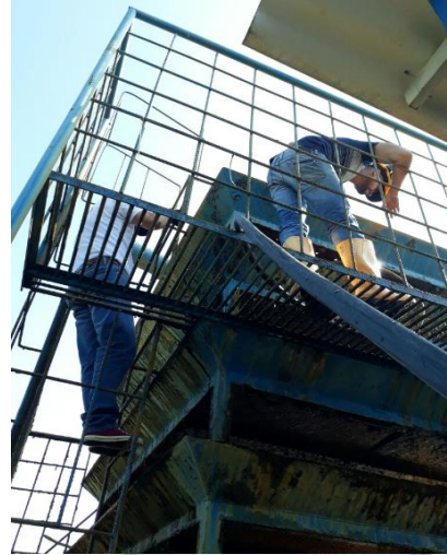
Fuente, tomada desde la torre de aireación.
