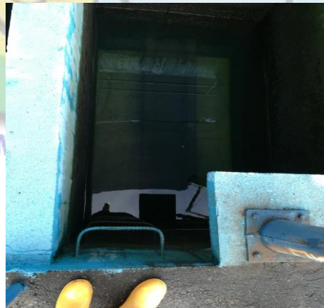
Fuente, tomada desde los lechos filtrantes.
