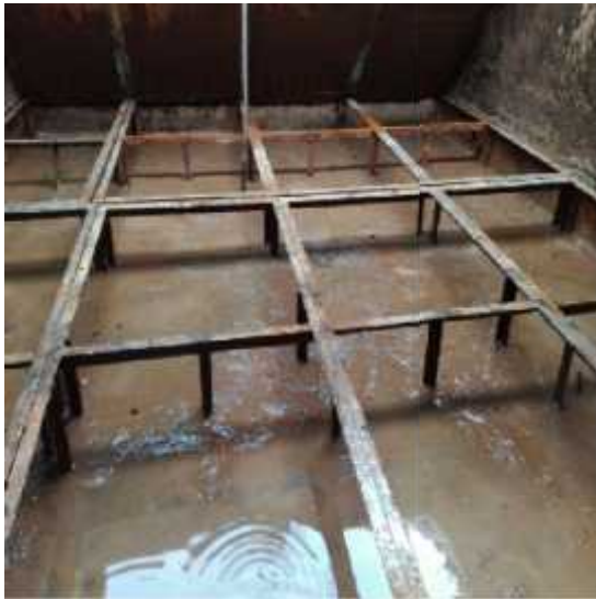
Ensamble estructura metálica y falso fondo.
