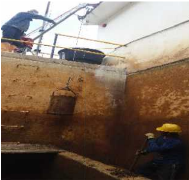
Retiro de material filtrante filtro N°1
