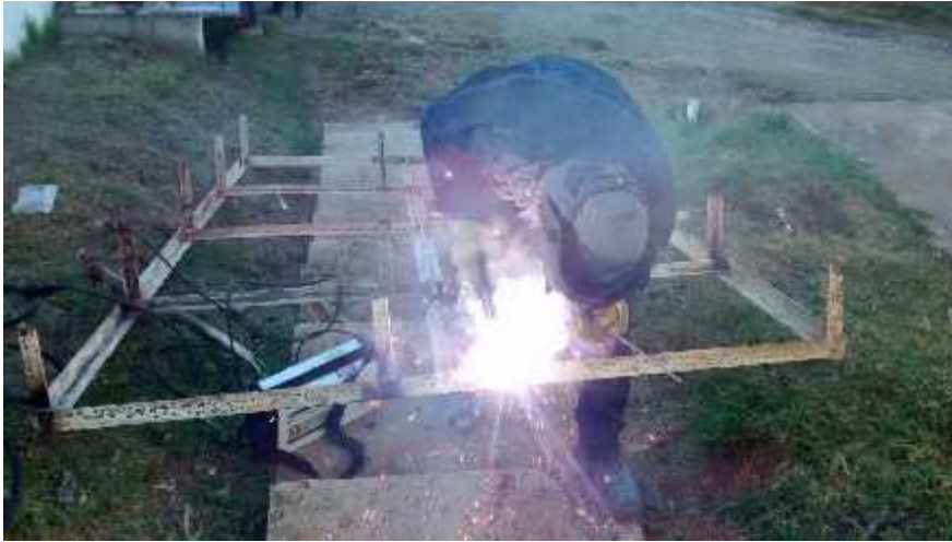
Reparación general y refuerzos estructura metálica.
