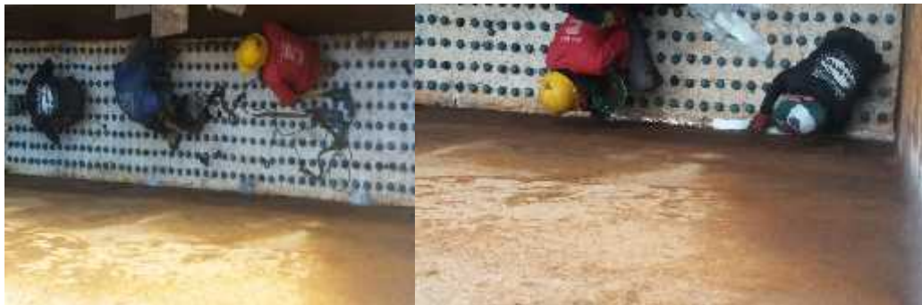
Instalacion falso fondo cambio de boquillas y pliegues en fibra de vidrio
