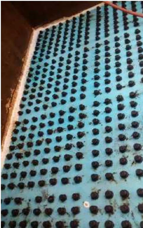
Ensamble estructura metálica y falso fondo.
