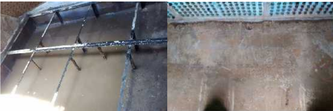
Ensamble estructura metálica y falso fondo.
