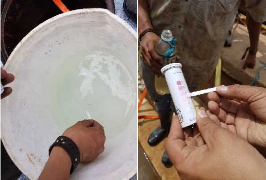
Medicion de partes por millon tanque a clorar.
