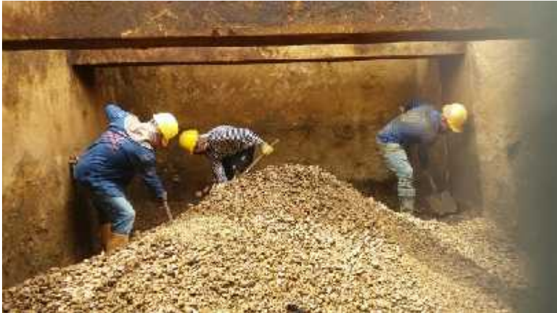
Extraccion de material existenetete del filtro directamente al volco
