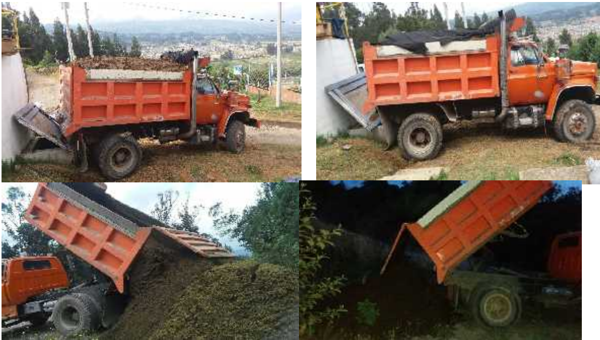
Retiro de material ya desinfectado en volqueta y disposición en el relleno sanitario
