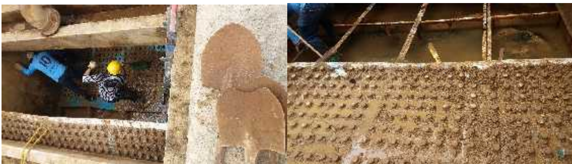
Levantamiento lamina falso fondo, para reparacion estructura metálica.
