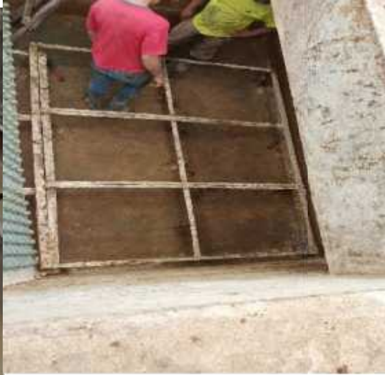
Ensamble estructura metálica y falso fondo.
