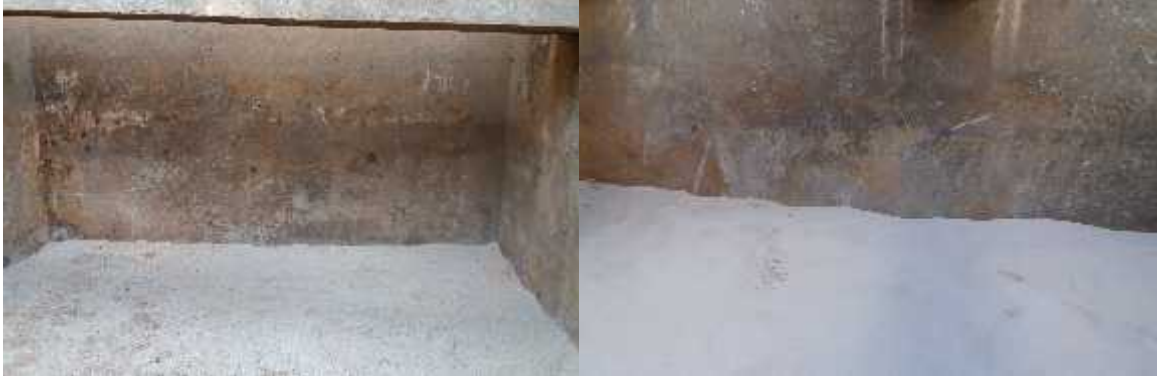
Primer lecho de arena
