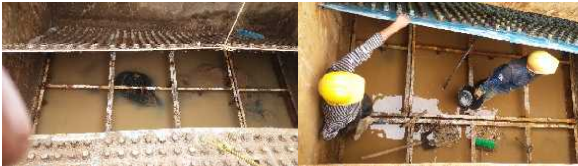
Falso fondo despues de retirado el material listo para lavado y levantamiento de laminas
