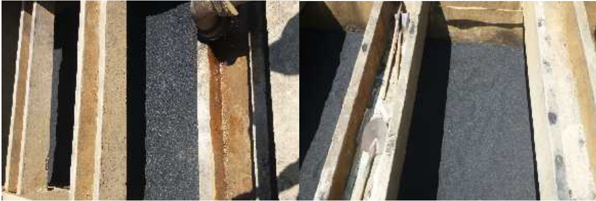
Lecho de antracita ya terminado. Filtro listo
