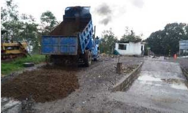
disposición en el relleno sanitario
