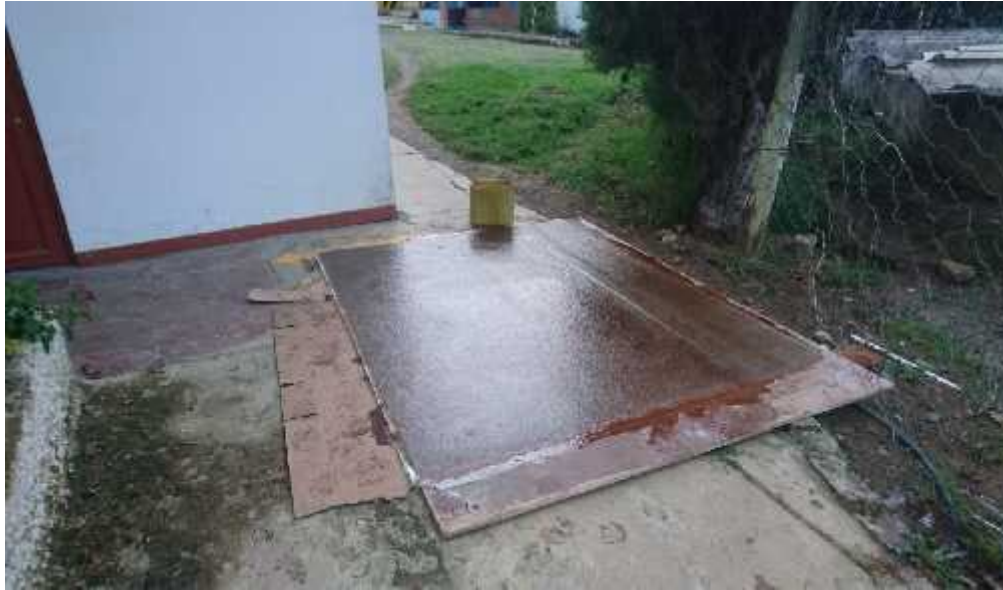
Lamina de poliuretano para aplicación de la fibra de vidrio
