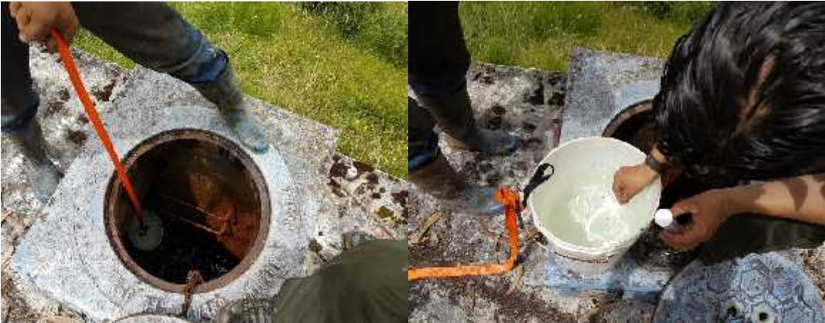
Medicion de partes por millon tanque a clorar.
