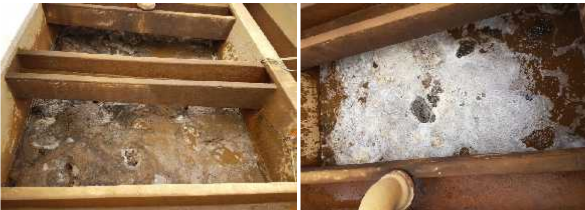
Llenado de agua en forma descendente con agua clorada para la desinfeccion.
