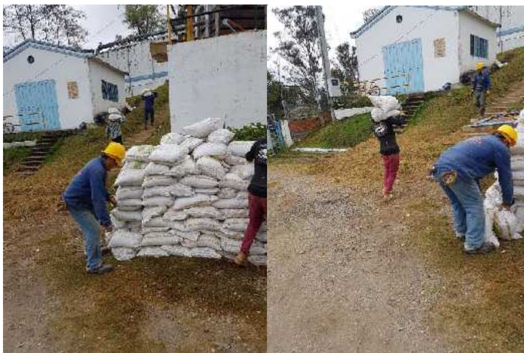
Subida de material al filtro N°1
