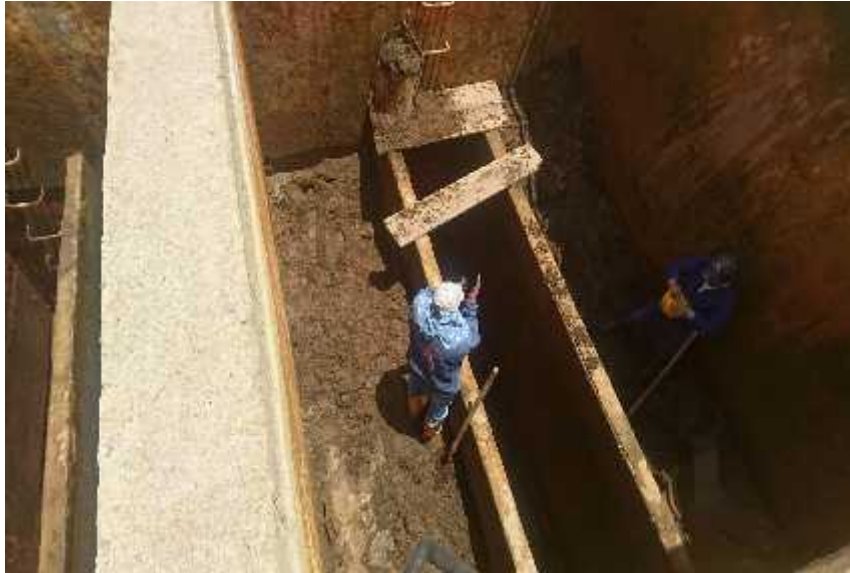
Extraccion de material existenete del filtro directamente al volco
