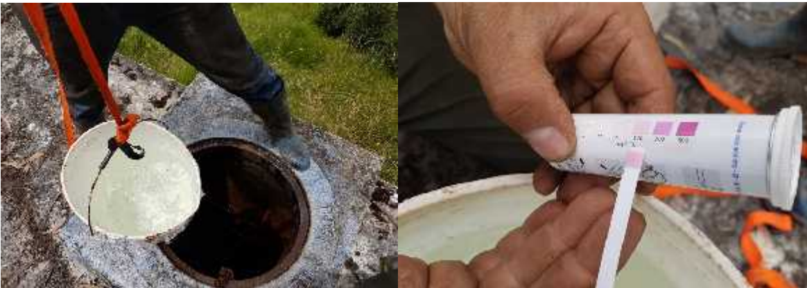
Comprobación medición agua clorada en 50 ppm para desinfección.
