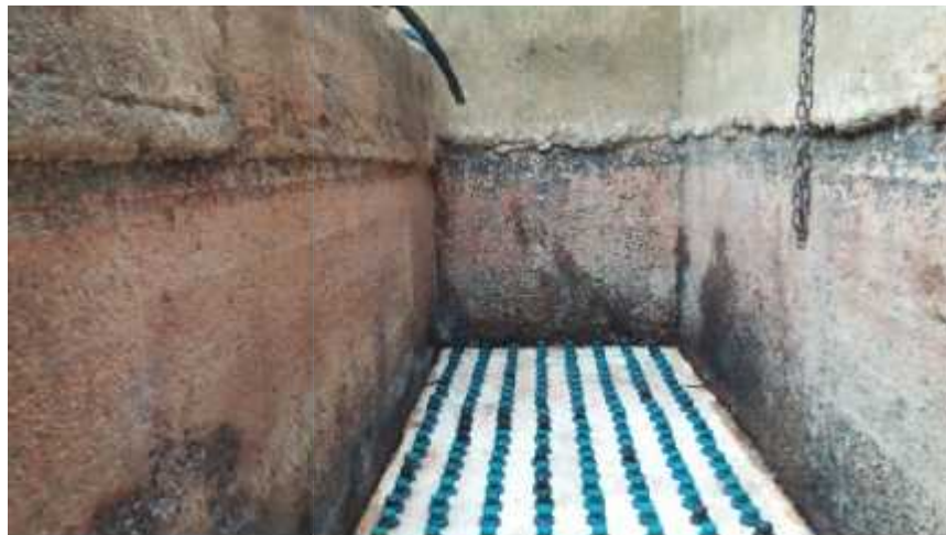
Marcacion con la cimbra para espesores de materiales granulares e inicio de llenado.
