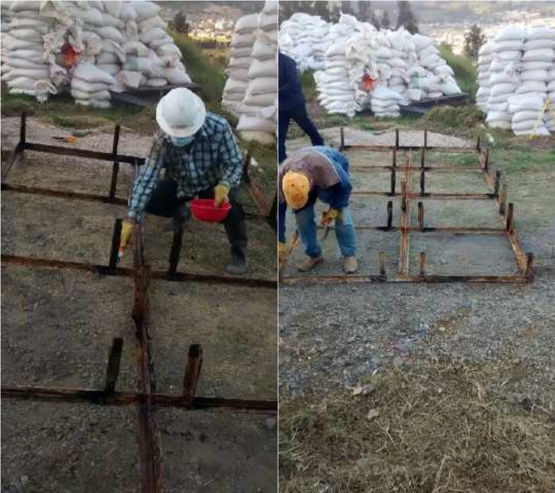
Recubrimiento en fibra de vidrio estructura metálica
