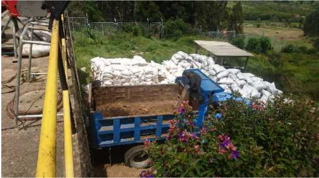
Retiro de material ya desinfectado en volqueta y disposición en el relleno sanitario
