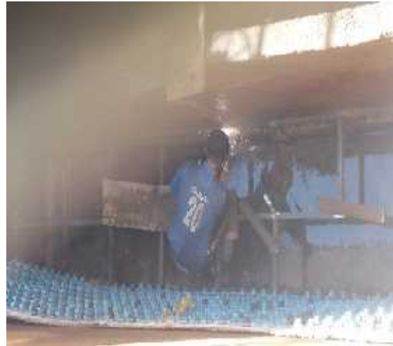
Levantamiento lamina falso fondo lavado y reparacion estructura, recubrimiento.
