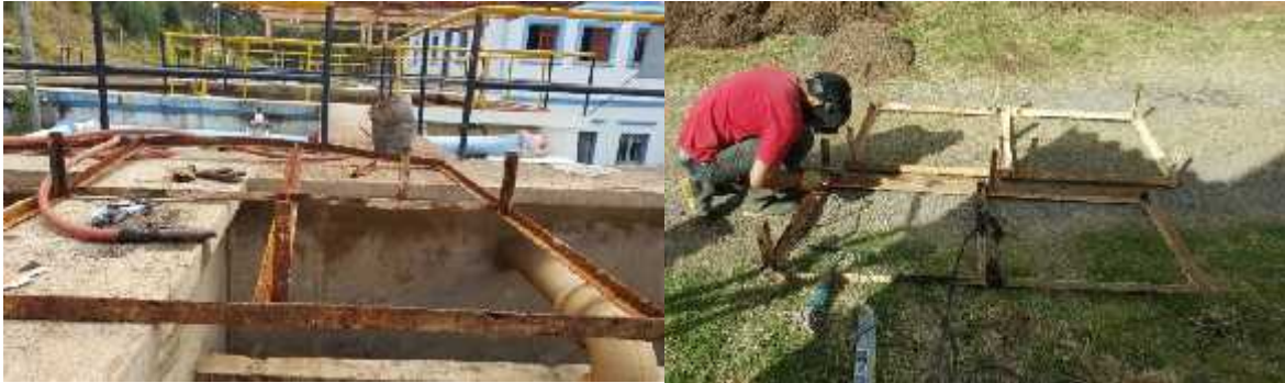
Reparación general y refuerzos estructura metálica.
