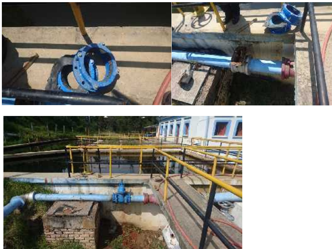
Reparación y cambio válvula de 8"
