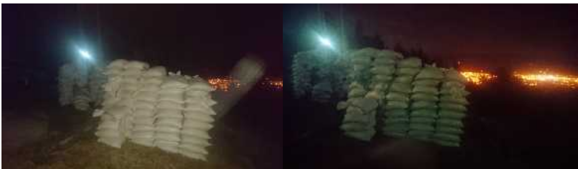
Material en planta de tratamiento terebinto.
