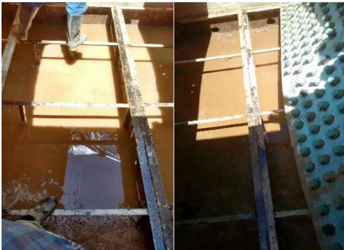
Levantamiento lamina falso fondo.
