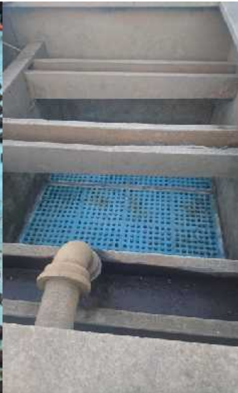
Ensamble estructura metálica y falso fondo.
