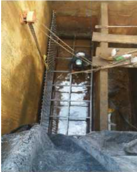
Levantamiento lamina falso fondo lavado y reparacion estructura, recubrimiento.
