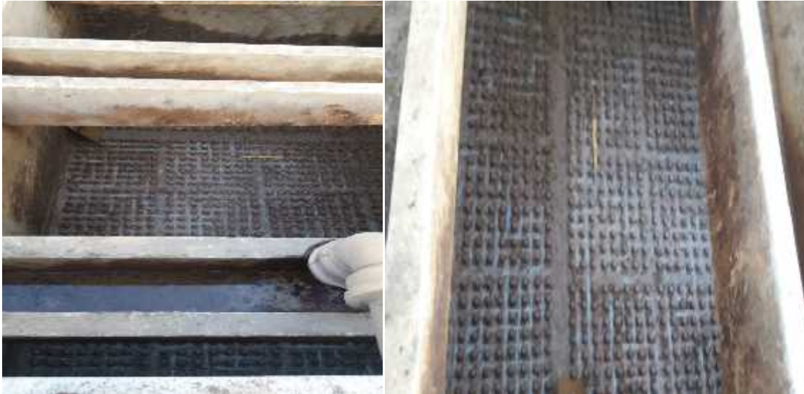
Falso fondo despues de retirado el material listo para lavado y levantamiento de laminas
