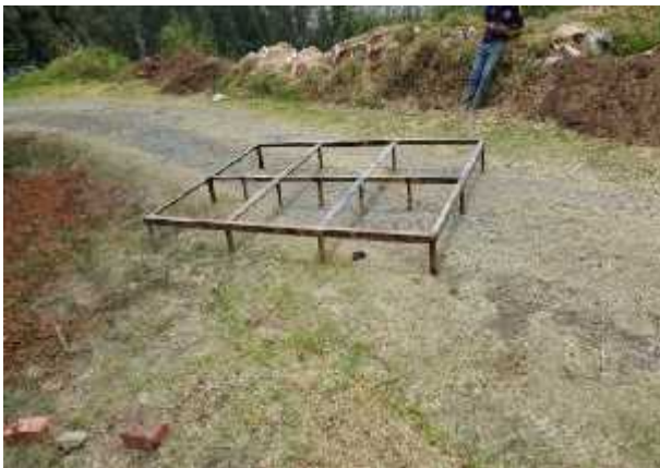
Recubrimiento en fibra de vidrio estructura metálica
