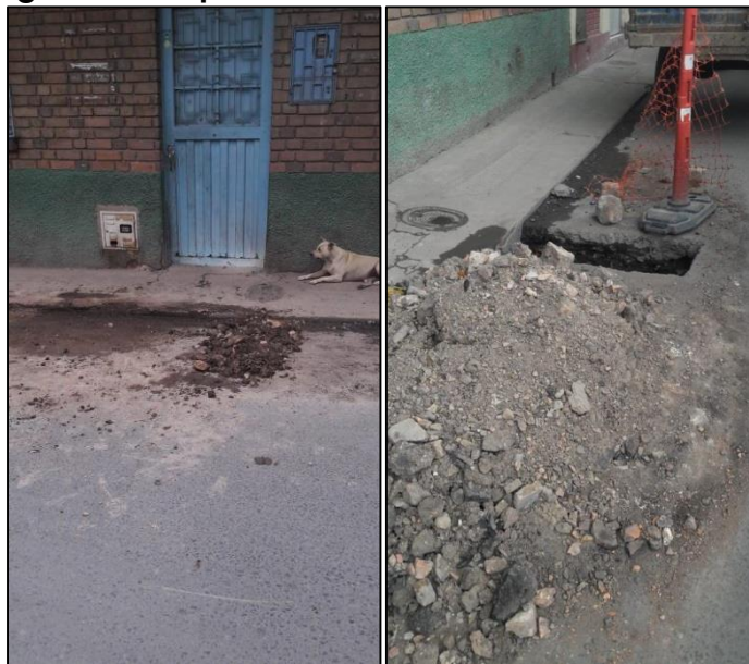
Fotografía 13: reparación instalacion calle 20 carrera 11
