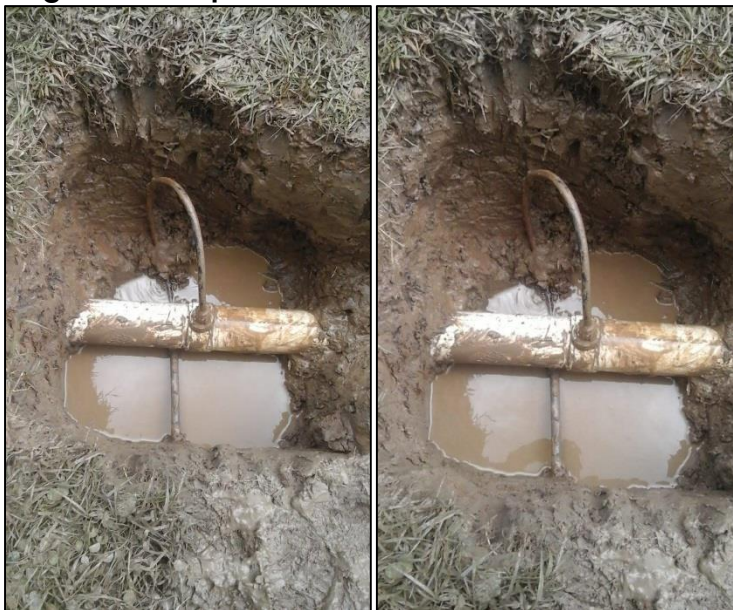
Fotografía 14: reparación instalación carrera 2A calle 2
