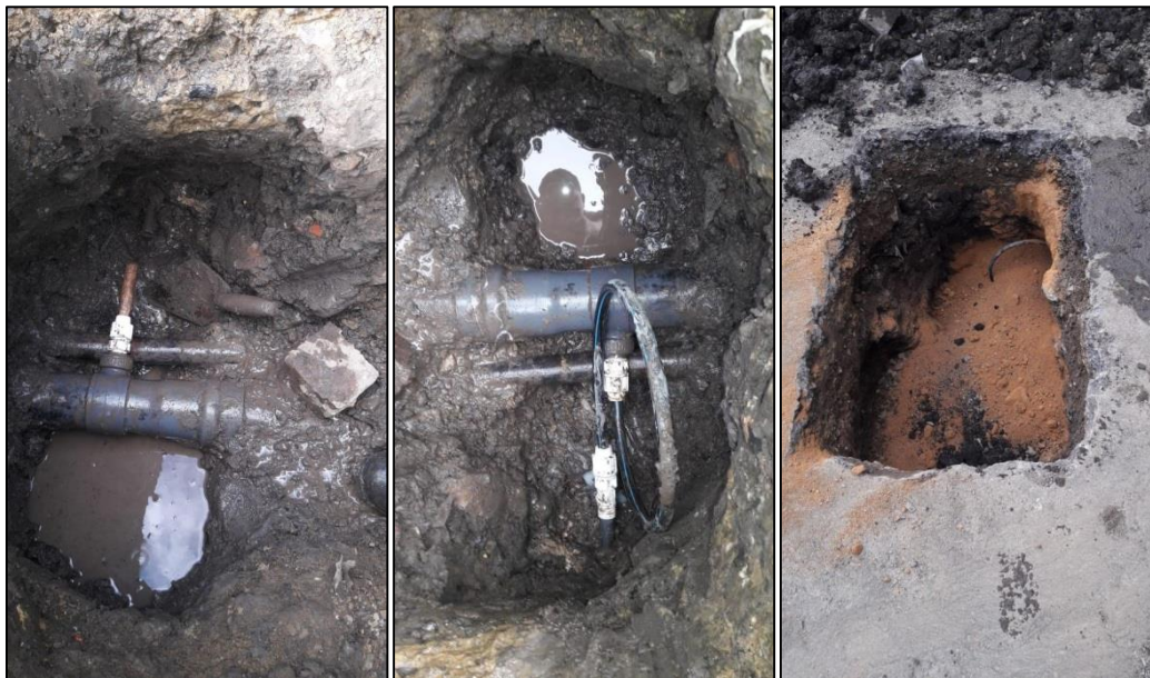
Fotografía 10: reparación tubería aducción 16"
