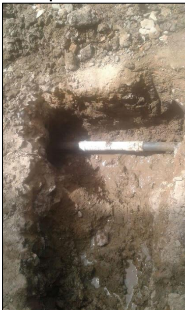
Fotografía 7: reparación tubería la pradera
