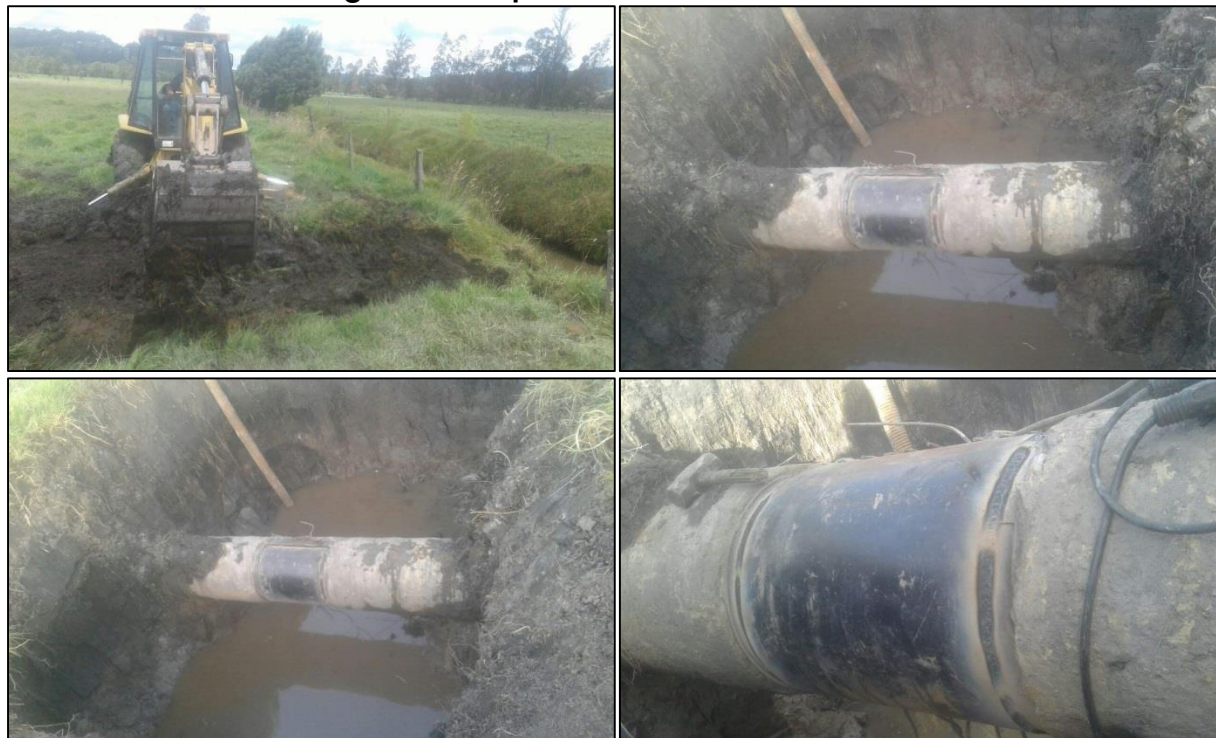
Fotografía 10: reparación tubería aducción 16"
