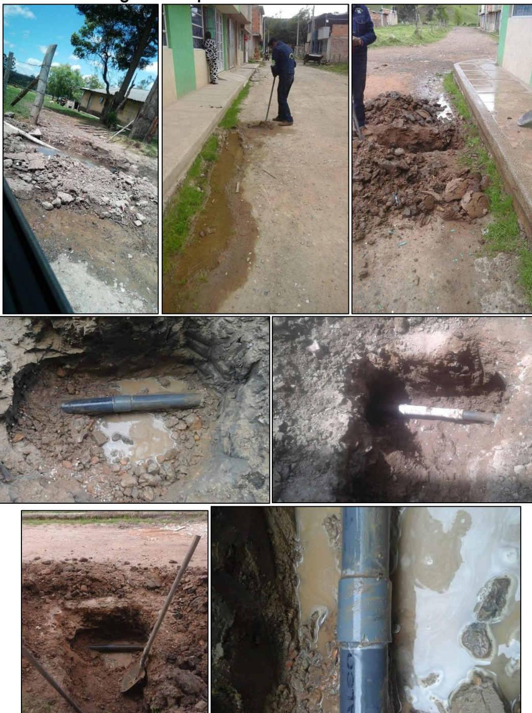
Fotografía 8: reparación tubería calle 9 carrera 3A
