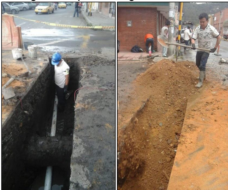
Fotografía 1: reparación fuga carrera 9 calle 11
