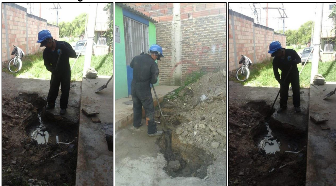
Fotografía 5: reconexión tubería carrera 10A calle 1
