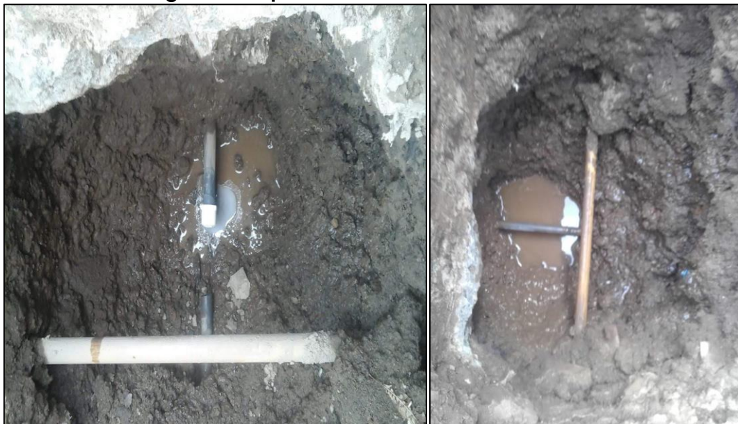
Fotografía 6: reparación tubería carrera 11 calle 22
