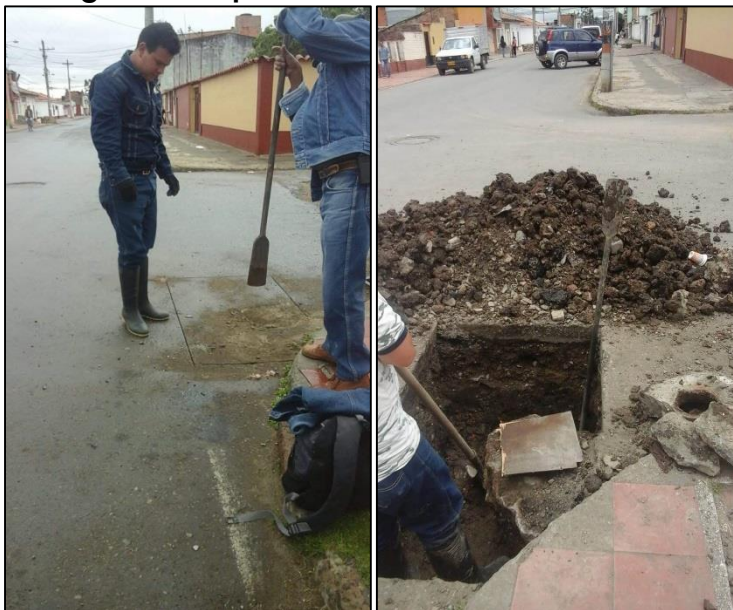
Fotografía 4: reparación tubería calle 15 carrera 5
