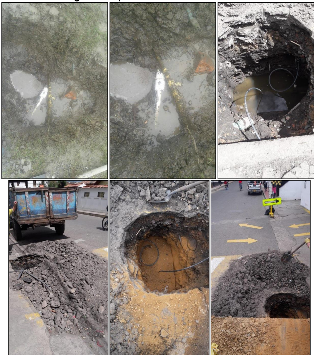
Fotografía 9: reparación tubería carrera 9 calle 14
