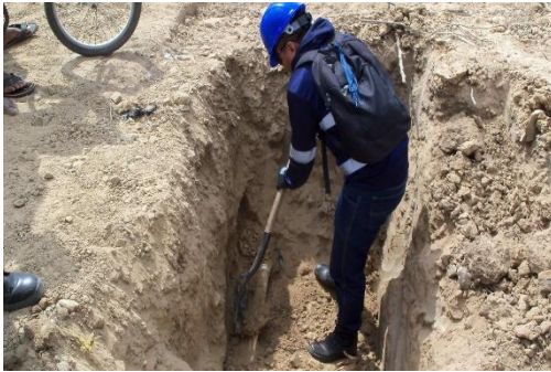
Búsqueda y Suspensiones de acometidas no autorizadas en la línea de conducción
