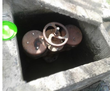
Retiro de ventosas en mal estado e instalación de nuevas ventosas para mejorar las condiciones hidráulicas de la línea de conducción.
