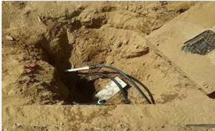
Usuario retira medidor instalado y se conecta de manera directa.
