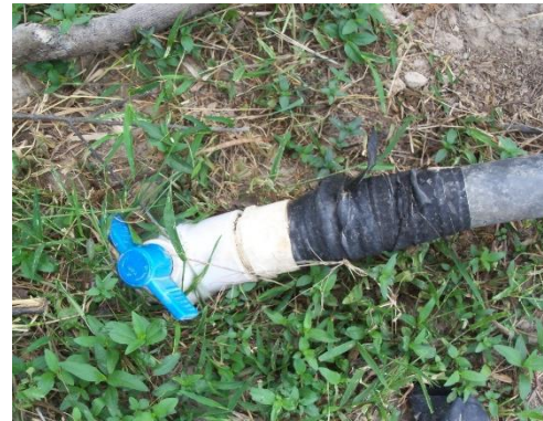
Suspensión de Acometida de 2" en la línea de conducción
