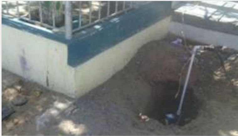
Usuario retira medidor e instala hidrobomba
