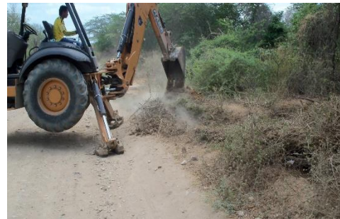
Búsqueda y Suspensiones de acometidas no autorizadas en la línea de conducción
