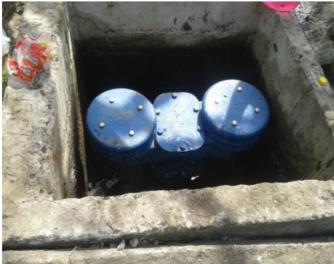
Retiro de ventosas en mal estado e instalación de nuevas ventosas para mejorar las condiciones hidráulicas de la línea de conducción.
