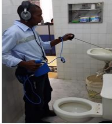
Identificación de fugas imperceptibles con ayuda de geófono
