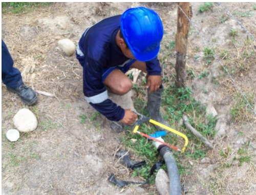
Suspensión de Acometida de 2" en la línea de conducción
