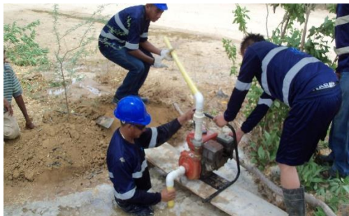
Búsqueda y Suspensiones de acometidas no autorizadas en la línea de conducción
