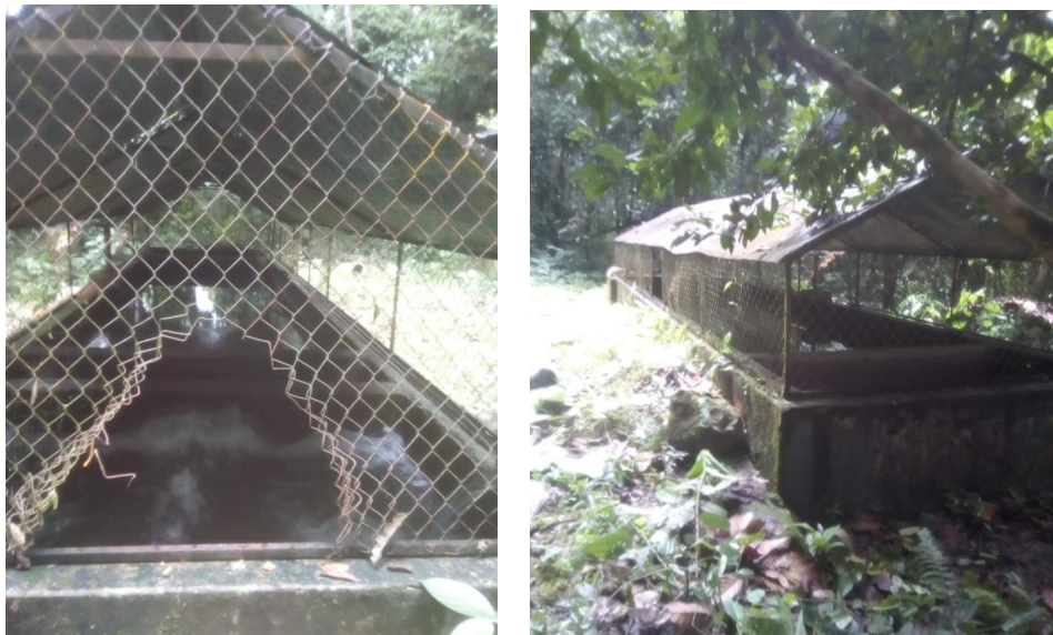
Imagen 5. Desarenador
