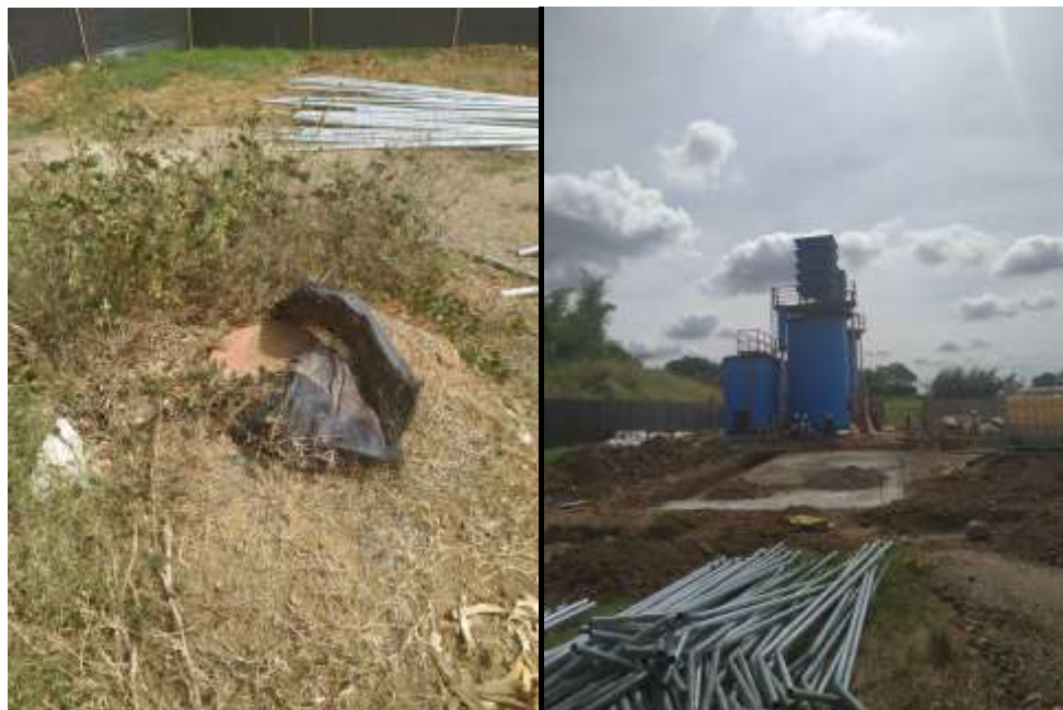
Imagen 26 Pozo y PTAP en construcción.
