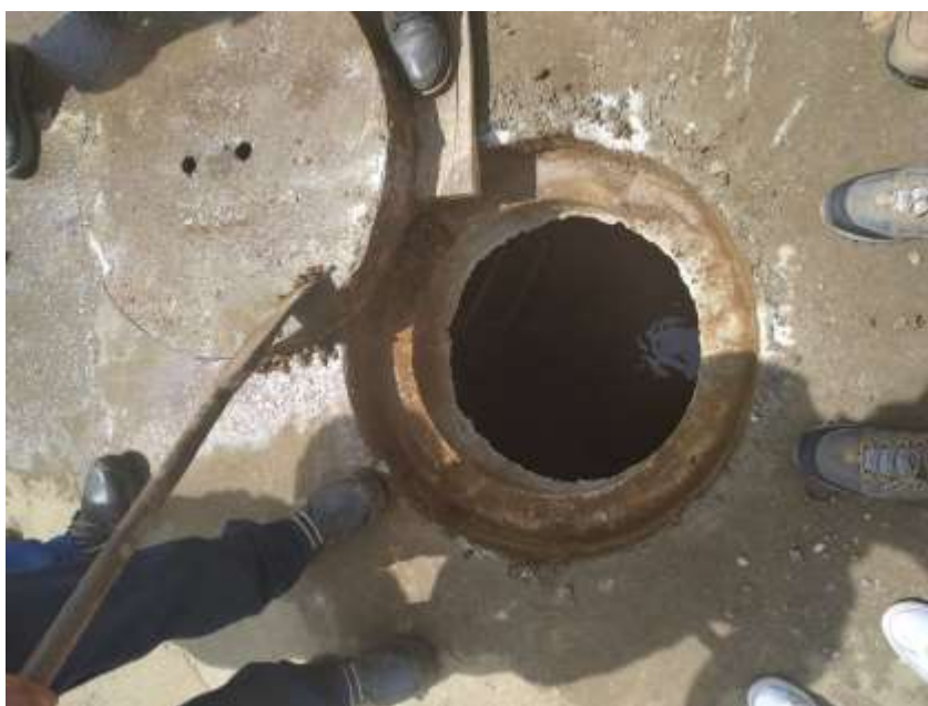
Imagen 33 Cámara de inspección Jamundí
