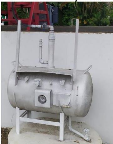
Ilustración 4 Tanques e destinado para el drenaje (residuo) de los cilindros
