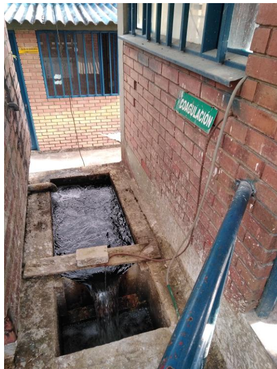
Imagen 11. Coagulación, PTAP. Fuente: Visita SSPD, 2017.
