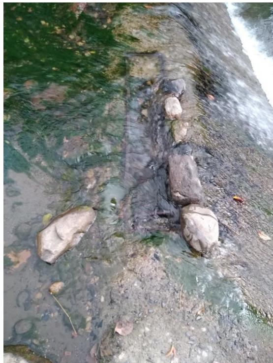
Imagen 4. Quebrada La Manotera, Bocatoma.
