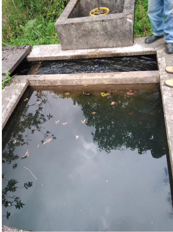
Imagen 6. Desarenador. Fuente: Visita SSPD, 2017.
