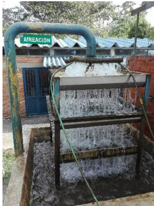
Imagen 9. Aireación, PTAP. Fuente: Visita SSPD, 2017.
