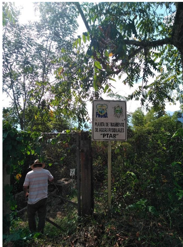
Imagen 20. Planta de tratamiento de aguas residuales. Fuente: Visita SSPD, 2017
