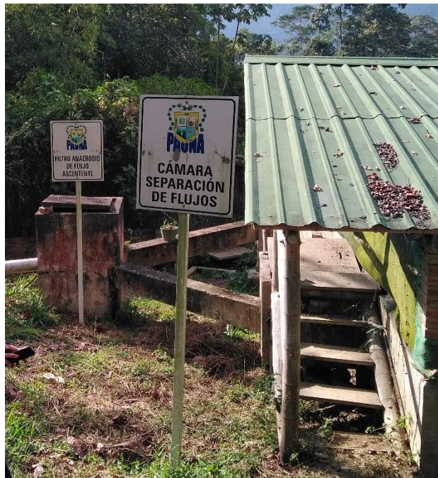
Imagen 24. Filtro anaerobio de flujo ascendente y cámara de separación de flujos. Fuente: Visita SSPD, 2017
