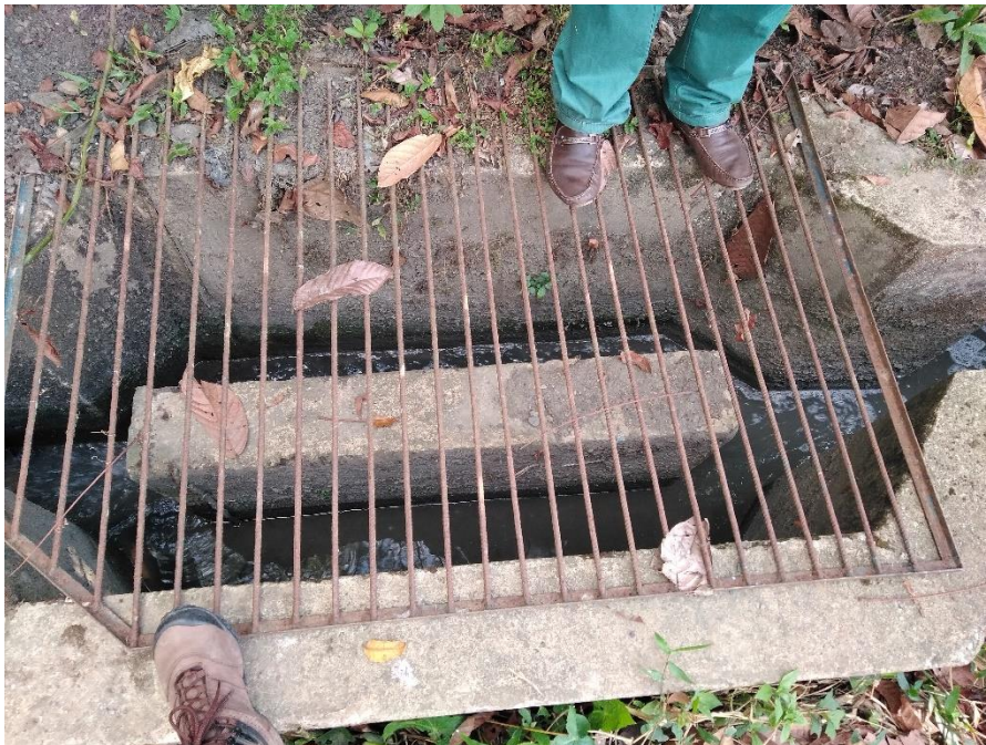
Imagen 22. Desarenador. Fuente: Visita SSPD, 2017
