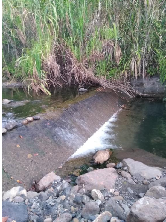
Imagen 3. Quebrada La Manotera, Bocatoma.
