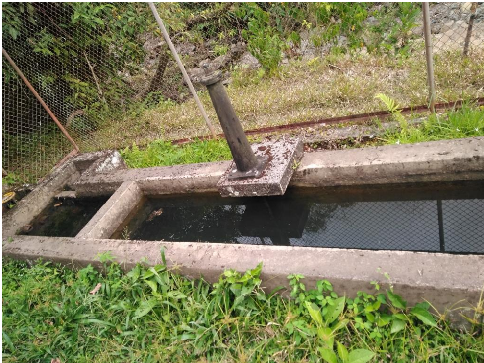
Imagen 7. Desarenador Fuente: Visita SSPD, 2017.
