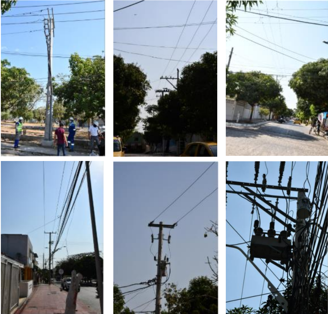
Gráfica 4-28 Registro fotográfico de acciones de normalización en riesgo eléctrico- Circuito 20 de julio
