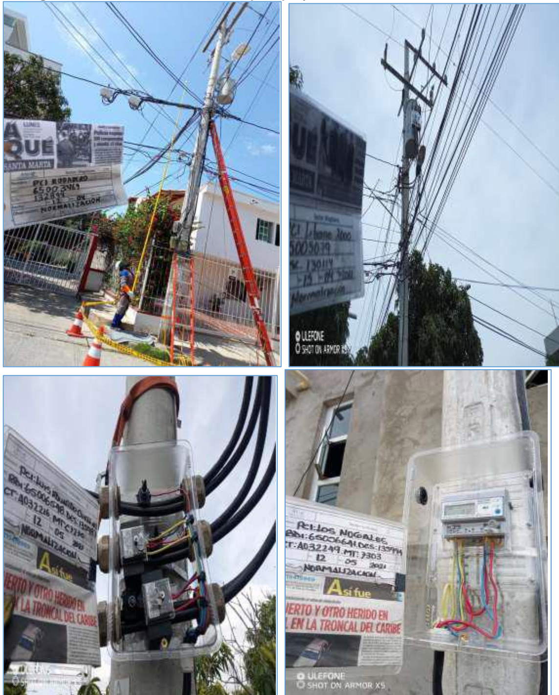
Imagen 11. Intervenciones realizadas para proyectos de instalación de macromedición
