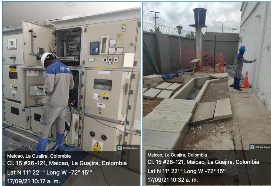
Imagen 2. Registro trabajos en fase final dentro de la subestación Maicao
