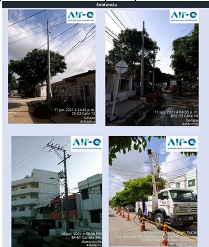
Imagen 13. Intervención de circuitos para la reposición de conductor ACSR
