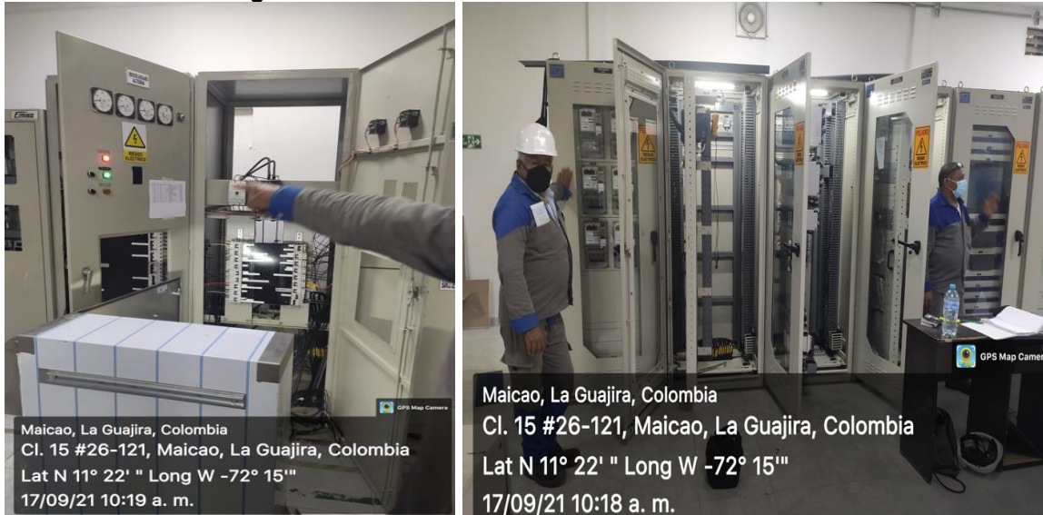
Imagen 4. Obras de inversión en la Subestación Maicao
