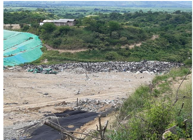
Foto 20. Vaso 3. Nótese chimeneas y frente de descargue
