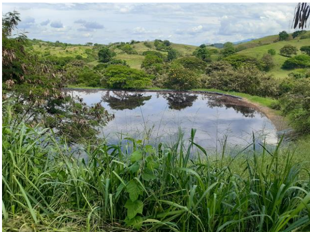
Foto 32. Vista de pondaje de lixiviados. Nótese la falta de mantenimiento del césped alrededor
