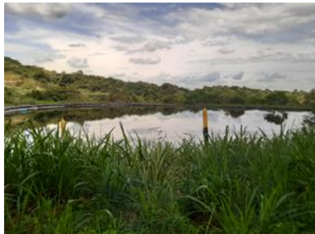
Foto 33. Vista de pondaje de lixiviados. Nótese la falta de mantenimiento del césped alrededor
