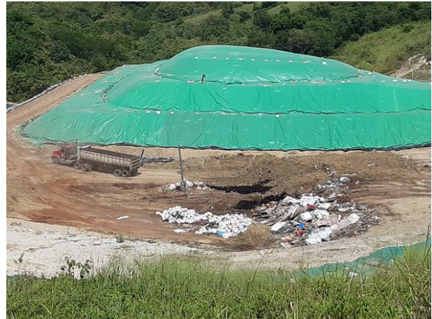
Foto 22. Detalle del Relleno La Esperanza en operación
