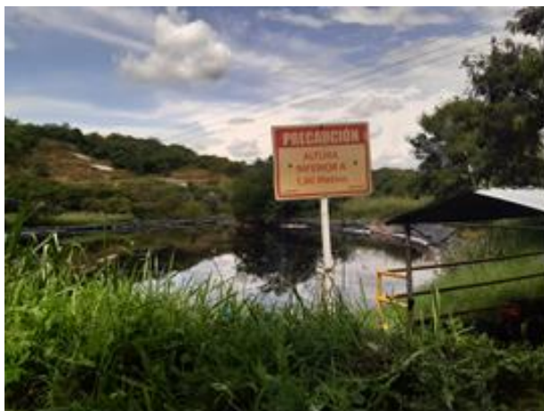
Foto 34. Vista de pondaje de lixiviados. Nótese la falta de mantenimiento del césped alrededor
