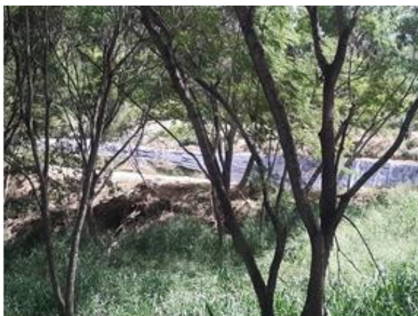
Foto 30. Vista de pondaje de lixiviados. Nótese la falta de mantenimiento del césped alrededor
