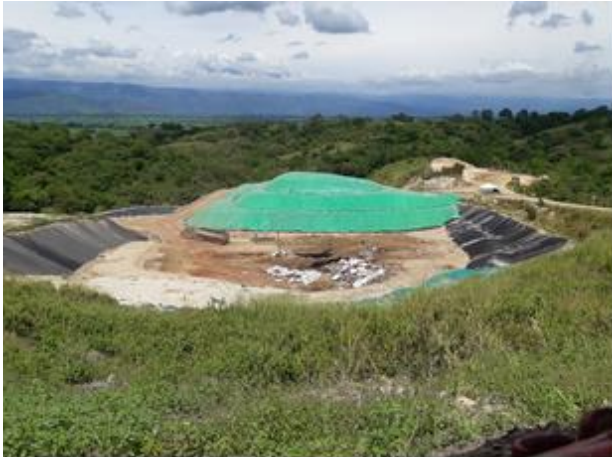
Foto 21. Vista general de la celda de seguridad o Relleno La Esperanza
