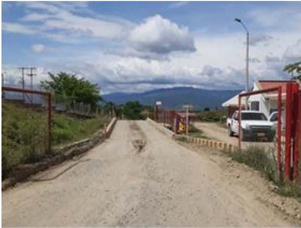
Foto 7. Báscula camionera ubicada a la entrada del relleno sanitario
