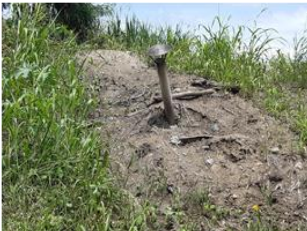
Foto 28. Detalle chimeneas de las zonas clausuradas
