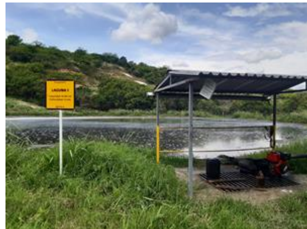
Foto 35. Vista de pondaje de lixiviados. Nótese la falta de mantenimiento del césped alrededor
