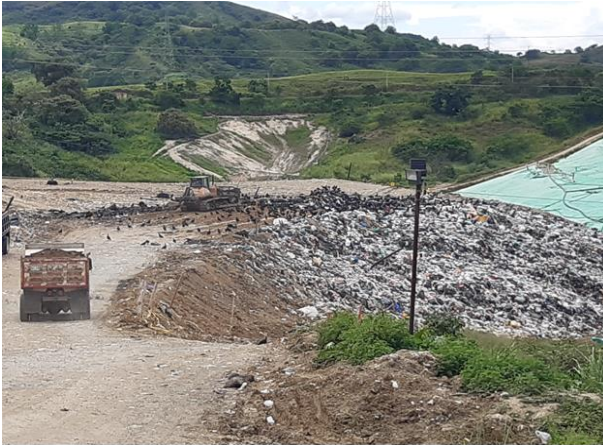
Foto 17. Vaso 3. Detalle del frente de descargue. Nótese la presencia de gallinazos
