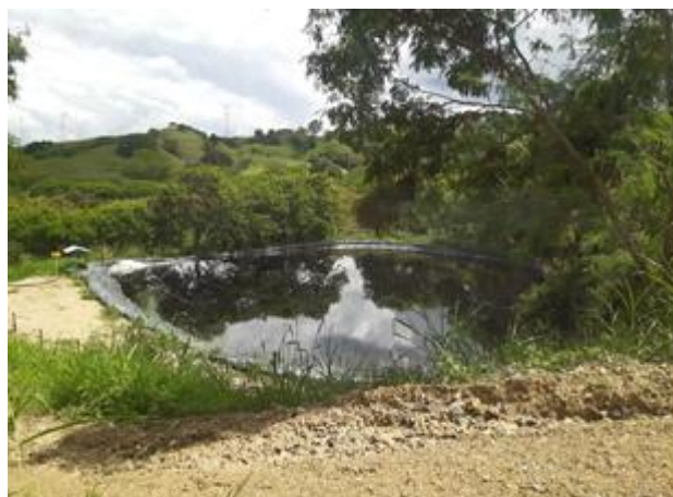
Foto 31. Vista de pondaje de lixiviados. Nótese la falta de mantenimiento del césped alrededor
