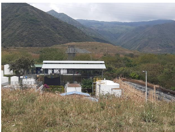
Foto 56. Vista general de la PTL
