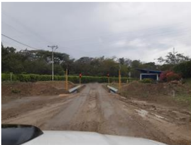
Foto 30. Vía de acceso antes de la báscula de entrada
