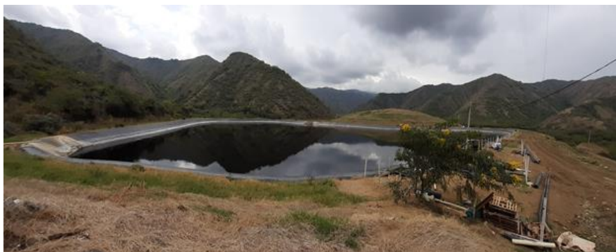
Foto 45. Laguna de homogenización
