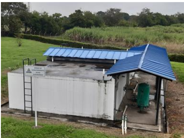
Foto 21. Tanque de almacenamiento de aguas subterráneas
