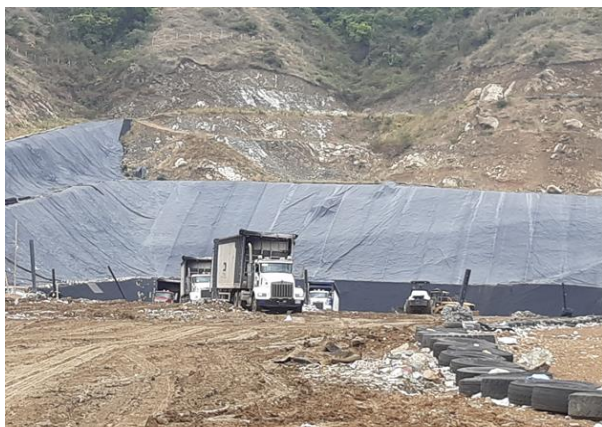
Foto 41. Entrada al frente de descargue de residuos
