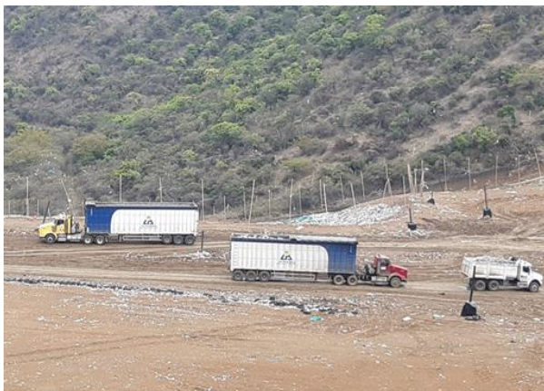
Foto 39. Entrada al frente de descargue de residuos
