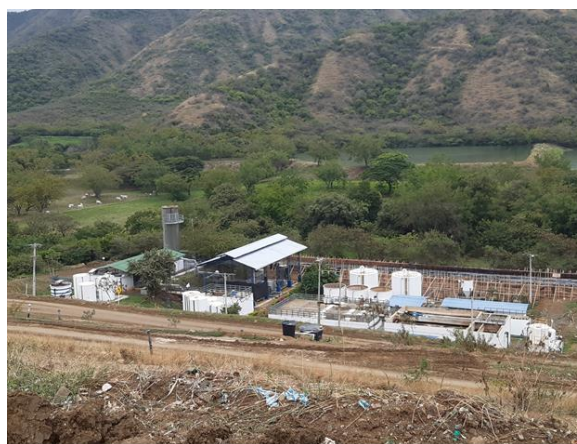
Foto 57. Vista general de la PTL
