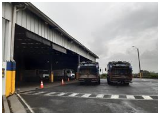
Foto 14. Entrada a la estructura de transferencia
