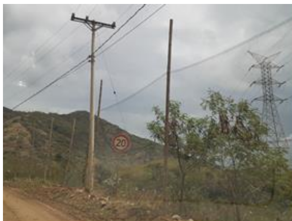
Foto 35. Señalización de velocidad máxima 20Km
