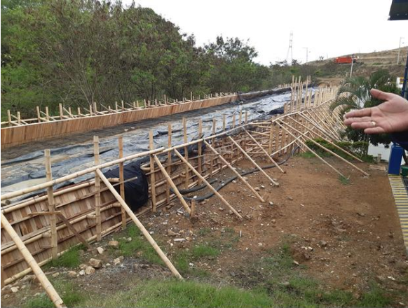
Foto 58. Muro de contención en construcción al lado de la PTL
