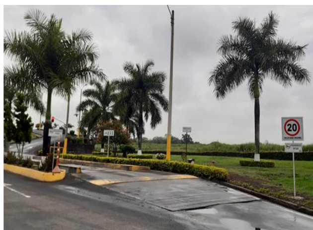
Foto 16. Señalización de las diferentes zonas del predio
