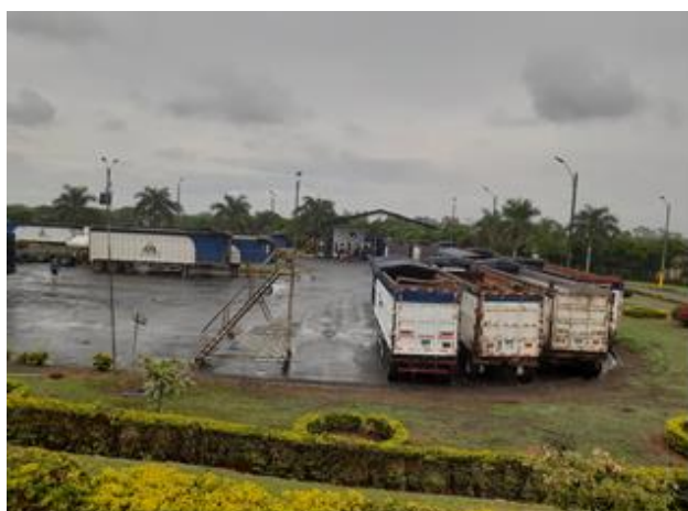
Foto 15. Área de parqueo de tráileres
