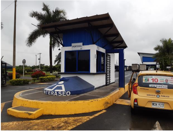
Foto 1. Portería vista externa.
