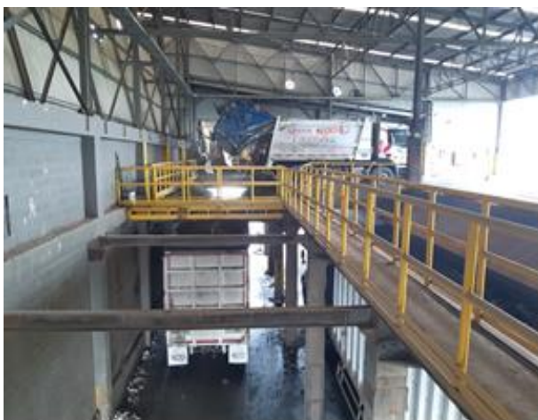
Foto 17. Estructura de transferencia. Vehículo compactador descargando al tráiler.
