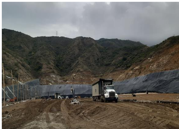
Foto 40. Entrada al frente de descargue de residuos
