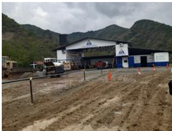
Foto 36. Zona de mantenimiento
