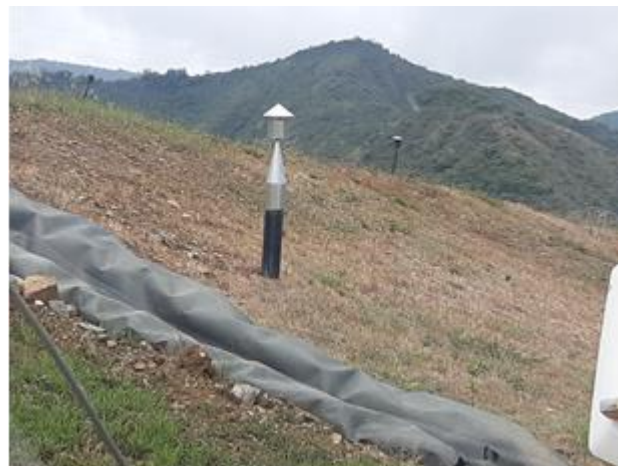
Foto 44. Chimeneas en zona clausuradas
