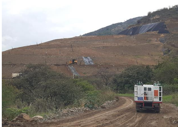
Foto 50. Vista general de la conformación de bermas y pendientes
