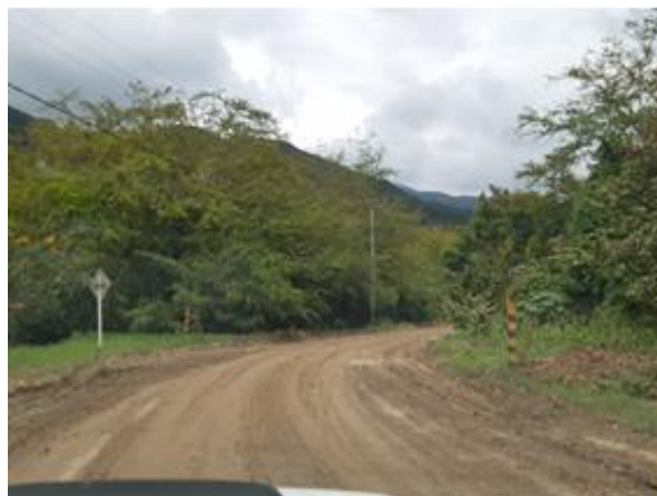
Foto 51. Vista general de la vía de acceso. Nótese ausencia de canalización de aguas lluvias
