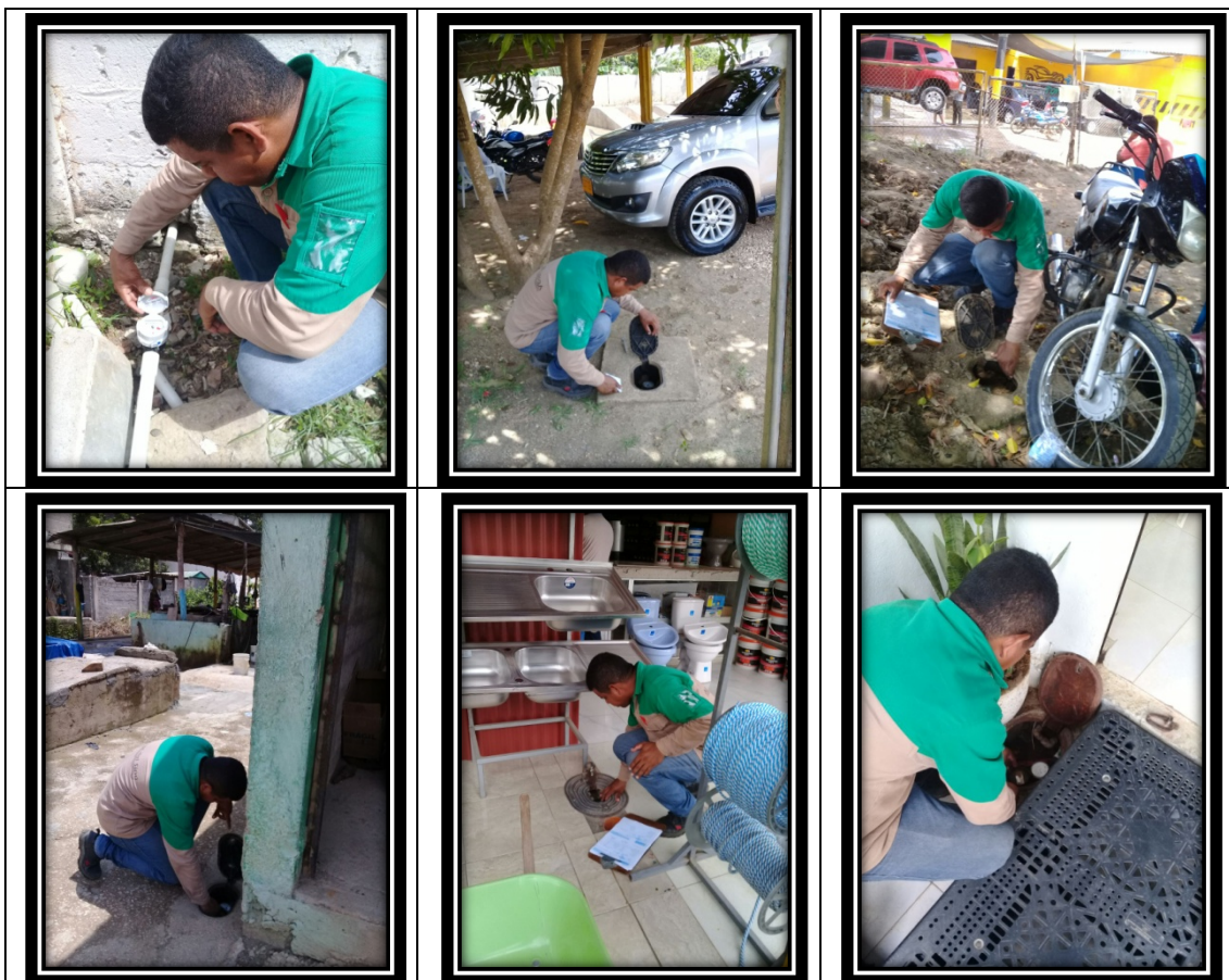
Fotos 7, 8, 9, 10, 11 y 12. Trabajos de visitas a grandes consumidores, tales como lavaderos, empresas empaquetadoras de agua potable, restaurantes y panaderías, ubicadas en el casco urbano del municipio. Véase en el Anexo 5.2.2.5.1.1. Formato de orden de revisión de servicios o revisión previa.
