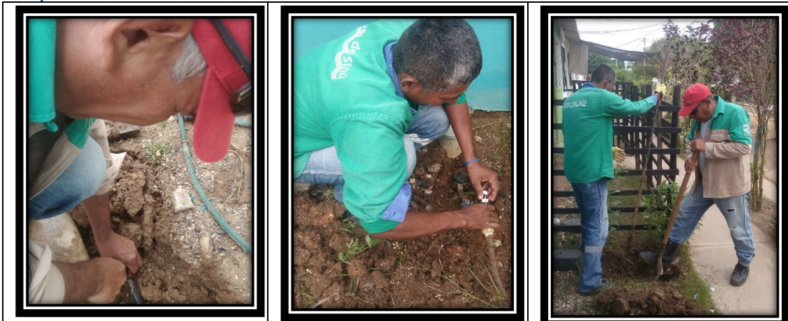
Fotos 19, 20 y 21. Trabajos de cortes y suspensiones del servicio de acueducto por incumplimiento de lo expuesto en los Capítulos V y VI – Título II - del Decreto 302 de 2000 que reza las causales de suspensión de los servicios y Causales de corte y finalización del contrato, la acción tuvo presencia en los barrios Las Lamas, San francisco y Rincón.
