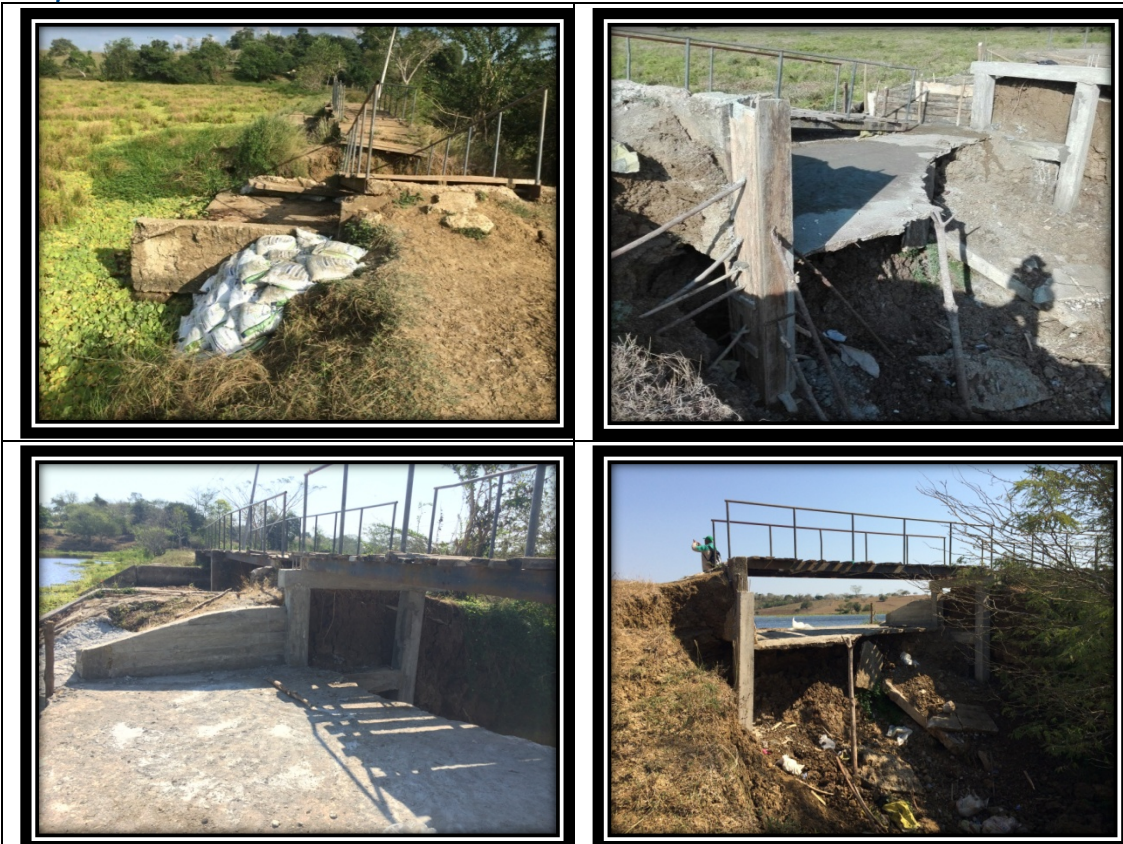
Foto 28, 29, 30 y 31: evidencias de trabajos realizados por la empresa Aguas del Sinú S.A E.S.P., para mitigar el daño causado por el invierno del año pasado a la estructura de vertimiento.
