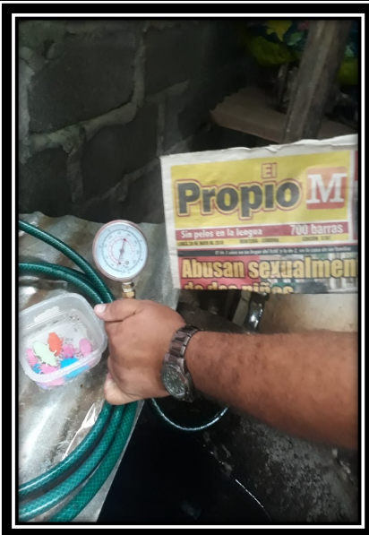
Fotos 48, 49 y 50. Evidencias fotográfica de medición de presión en conexión intradomiciliaria
