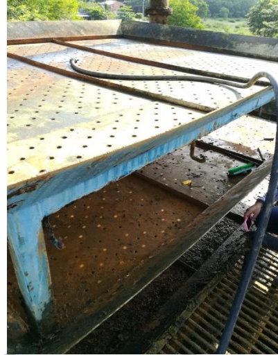
Fuente, tomada desde la torre de aireación.
