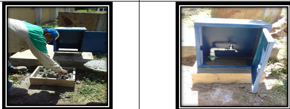
Fotos 115, 116 y 117. Evidencia fotográfica de limpieza y mantenimiento del sitio del punto de muestreo, y de la reposición de la caja.
