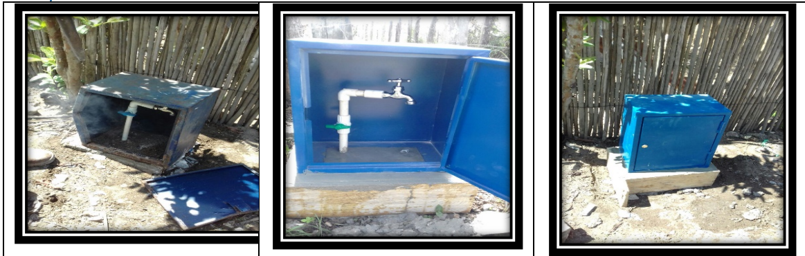
Fotos 109, 110 y 111. Evidencia fotográfica de limpieza y mantenimiento del sitio del punto de muestreo, y de la reposición de la caja.
