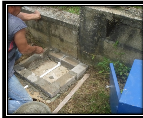
Fotos 139 y 140. Evidencia fotográfica de la instalación del nuevo punto de muestreo.
