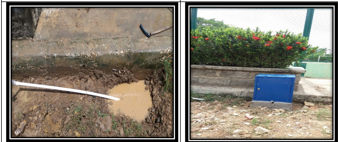
Fotos 107 y 108. Evidencia fotográfica de limpieza y mantenimiento del sitio del punto de muestreo, y de la reposición de la caja.
