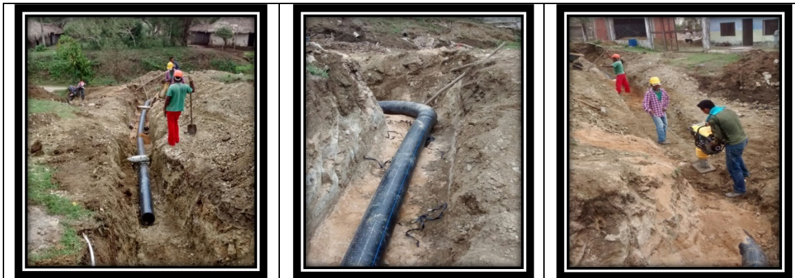
Foto 27,28 y 29. Actividades adelantadas en la instalación de nuevo tramo de EBAP Las Cruces hasta Tanque elevado ubicado en el municipio de San Andrés de Sotavento en tubería PEAD de 8" en aras de optimizar red de impulsión.
