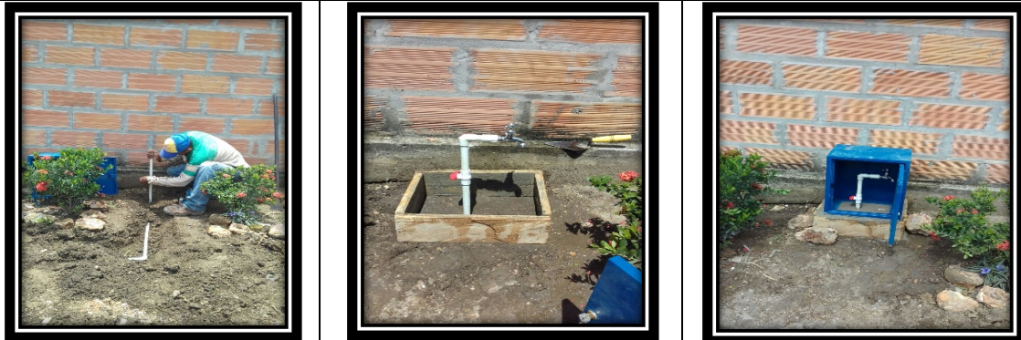
Fotos 112, 113 y 114. Evidencia fotográfica de limpieza y mantenimiento del sitio del punto de muestreo, y de la reposición de la caja.
