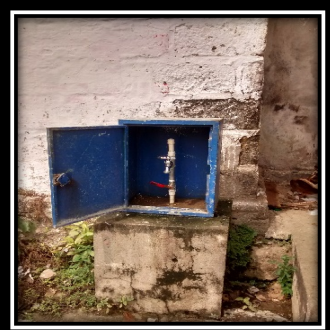
Fotos 136, 137 y 138. Evidencia fotográfica de la instalación del nuevo punto de muestreo.
