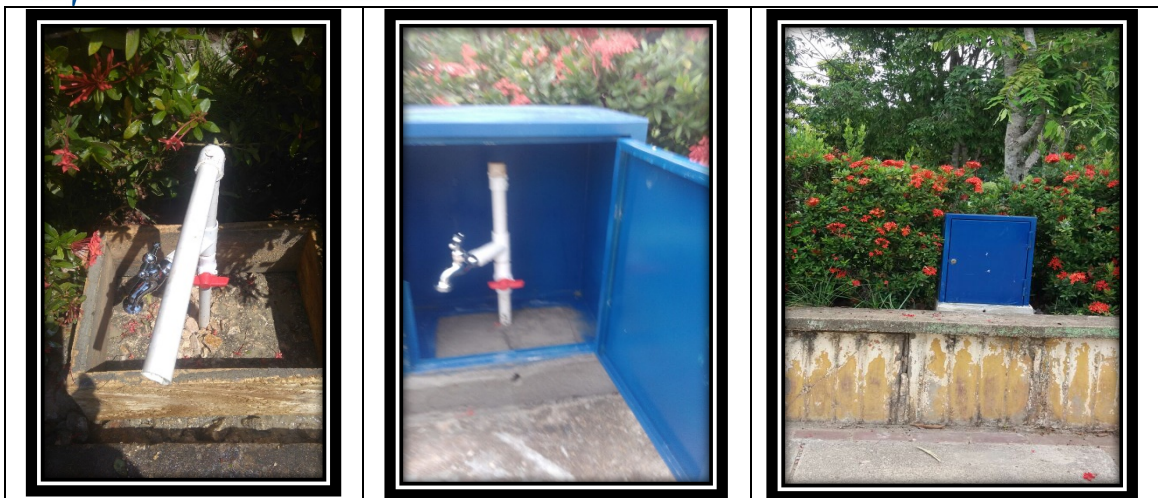
Fotos 97, 98 y 99. Evidencia fotográfica de limpieza y de la reposición de la caja.
