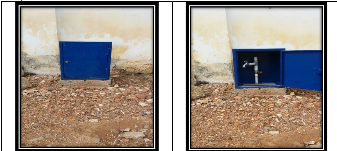
Fotos 105 y 106. Evidencia fotográfica de limpieza y mantenimiento del sitio del punto de muestreo, y de la reposición de la caja.
