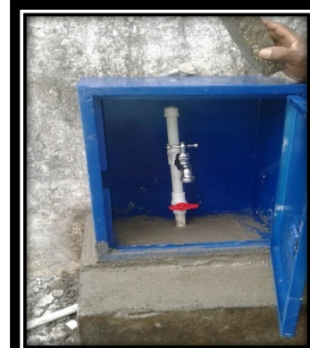
Fotos 141, 142 y 143. Evidencia fotográfica de la instalación del nuevo punto de muestreo.
