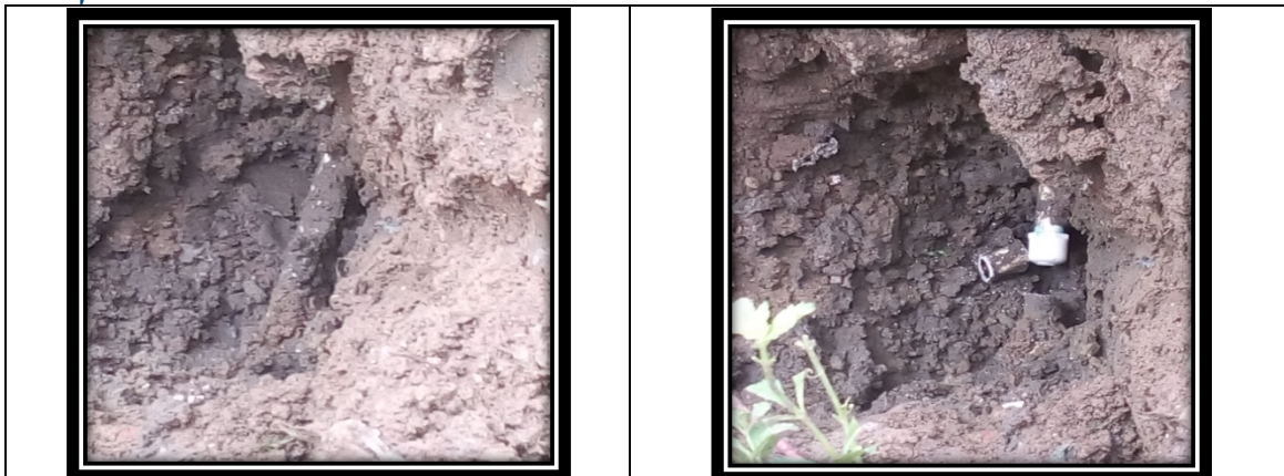
Fotos 25, y 26. Trabajos de cortes y suspensiones del servicio de acueducto por incumplimiento de lo expuesto en los Capítulos V y VI – Titulo II - del Decreto 302 de 2000 que reza las causales de suspensión de los servicios y Causales de corte y finalización del contrato, las actividades estuvieron situadas en el barrio boca canoa.
