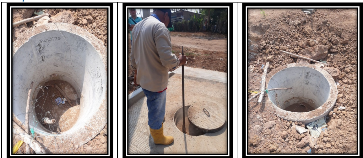
Fotos 149, 150 y 151 . Evidencia fotográfica de la construcción de nuevas cámaras de inspección y nuevos tramos de alcantarillado en el municipio de Momil.
