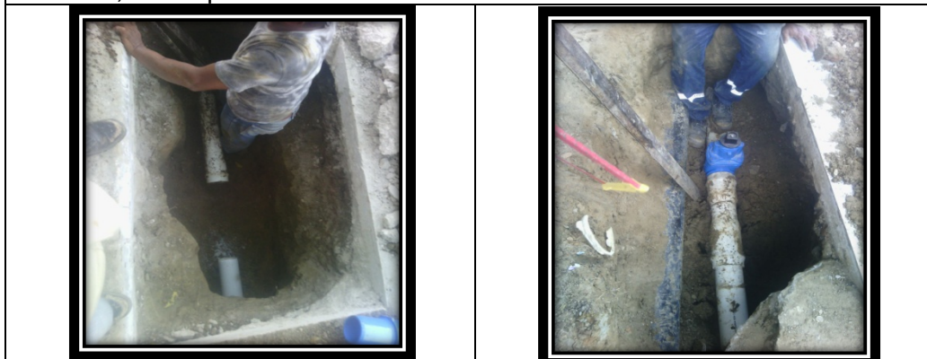
Foto 175 y 176. Reemplazo de dos válvulas de compuerta 4" en barrio Puesto seco, municipio de San Andrés de Sotavento.
