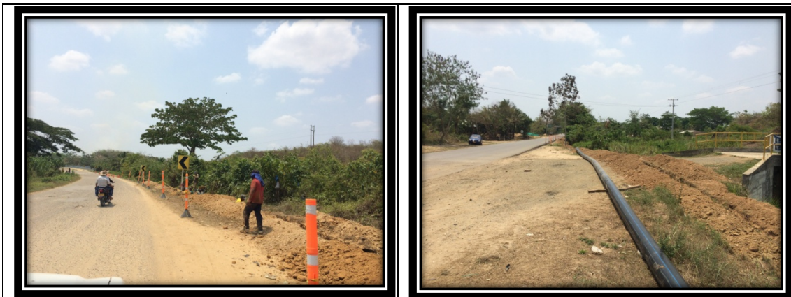
Foto 25 y 26. Actividades adelantadas en la instalación de nuevo tramo de EBAP Las Cruces hasta Tanque elevado ubicado en el municipio de San Andrés de Sotavento en de tubería PEAD de 8” en aras de optimizar redes de impulsión.
