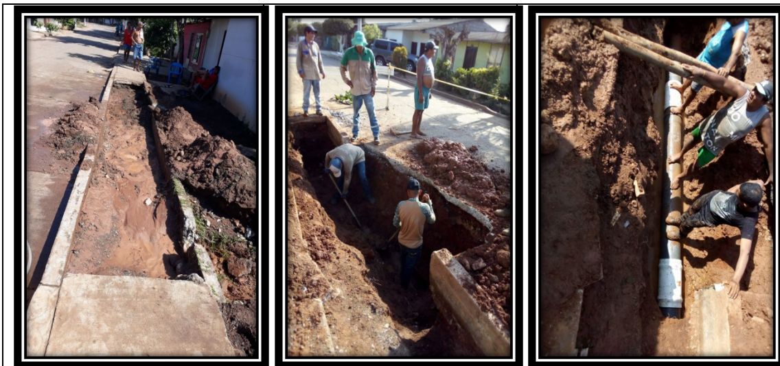
Fotos 13, 14 y 15. Trabajos de reparación de fugas presentadas en las líneas de conducción PTAP Lorica – Tanque de almacenamiento Nueva Colombia. Se evidencia el gran volumen de excavación que se requirió realizar para llevar a cabo la reparación de la fuga.
