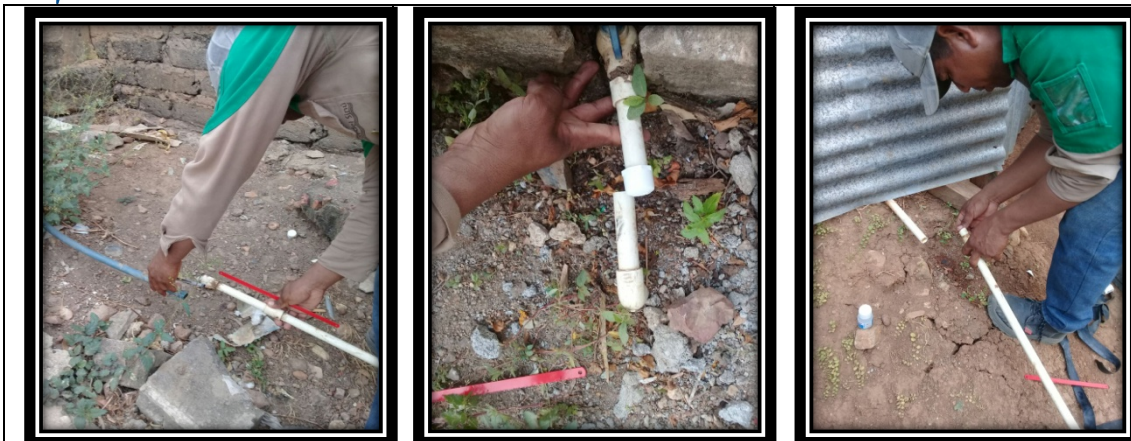
Fotos 1, 2, 3, 4, 5 y 6. Trabajos de cortes y suspensiones del servicio de acueducto por incumplimiento de lo expuesto en los Capítulos V y VI – Título II - del Decreto 302 de 2000 que reza las causales de suspensión de los servicios y Causales de corte y finalización del contrato, las actividades estuvieron situadas en los barrios Alto Kennedy, Alto Prado, Santo Domingo y Nueva Colombia.
