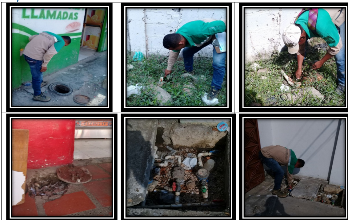
Fotos 7, 8, 9, 10, 11 y 12. Trabajos de visitas a grandes consumidores, tales como lavaderos, empresas empaquetadoras de agua potable y panaderías, ubicadas en el casco urbano del municipio. Véase en el Anexo 5.2.2.3.1.1. Formato de orden de revisión de servicios o revisión previa.
