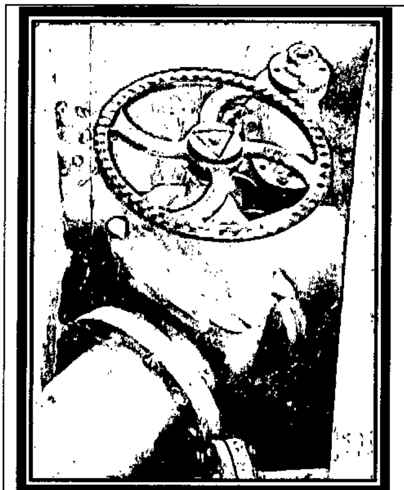
Fotos 14. Válvula 10", instalada en el sistema del bombeo Captación Lorica – PTAP Lorica. Trabajo necesario para habilitación de línea de impulsión en tubería PVC 12".
