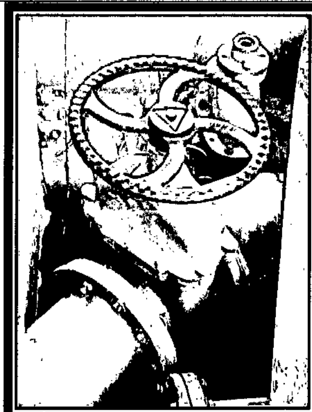
Fotos 14. Válvula 10", instalada en el sistema del bombeo Captación Lórica – PTAP Lórica. Trabajo necesario para habilitación de línea de impulsión en tubería PVC 12".
