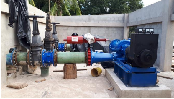
Turbina generadora de energía (Proyecto de optimización)
