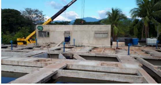
Construcción Optimización PTAP
