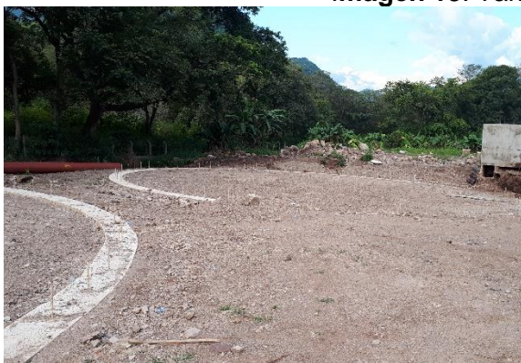
Espacio para construcción de nuevos tanques de almacenamiento
