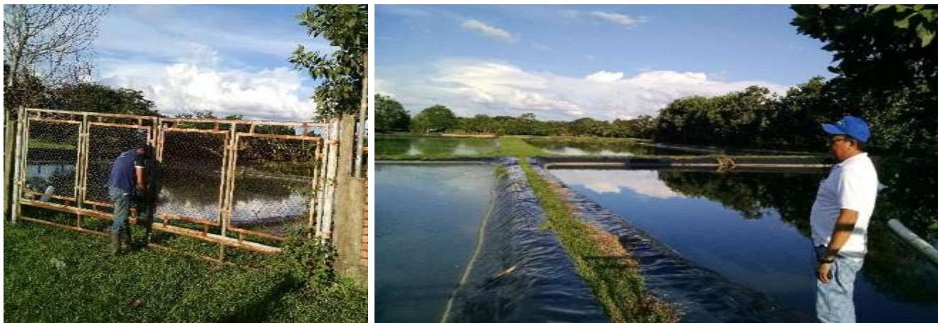
Imágenes 31 y 32: Se presenta la PTAR del municipio de Cravo Norte, inspeccionada en la visita efectuada en junio de 2017.
