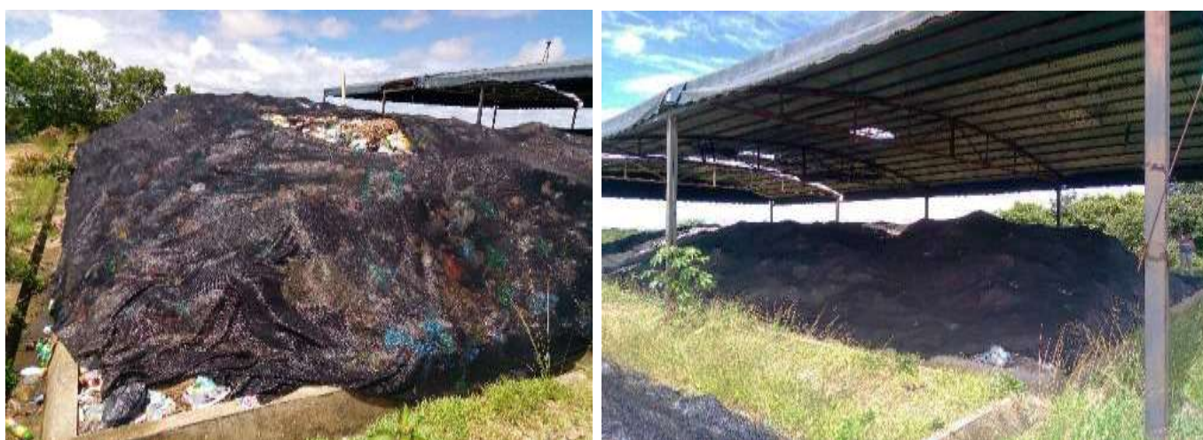
Imágenes 51 a 54: En su orden, se presenta la plataforma de descarga de residuos del Relleno Sanitario El Totumo, la celda No. 3 (actualmente en operación), la celda No. 2 (con cubierta de polisombra) y la celda No. 1 (con polisombra y tejado).
