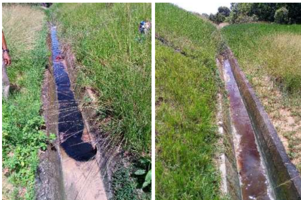
Imágenes 63 a 67: En las imágenes superiores se observa la red de canales recubiertos en concreto, mediante los cuales se manejan las aguas lluvias en la zona adyacente a las celdas; y el punto de descarga de las mismas en el sector suroriental de las celdas, sobre una canal en tierra que sale del predio. Nótese la acumulación de residuos plásticos en dicho punto. Abajo se presenta el ducto procedente de la celda No. 3, descargando agua de color oscuro y olor característico de agua residual con alto contenido orgánico (lixiviado), sobre la canal perimetral oriental de la celda No. 3.
