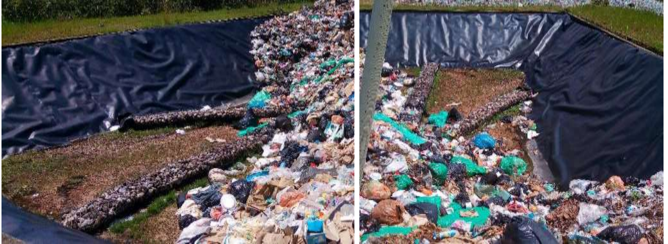
Imágenes 57 a 62: En las imágenes superiores se observa la celda 3 (en uso), dotada de geomembrana de fondo en buen estado, y los canales de recolección y conducción de lixiviado a través de filtros en piedra. Abajo se ilustra el pondaje de almacenamiento de lixiviado, dotado de cubierta y geomembrana; así como el ducto a través del cual se bombea el agua residual para ser vertida en el suelo adyacente al pondaje, donde se notorio un proceso de socavación asociada a dicha actividad.
