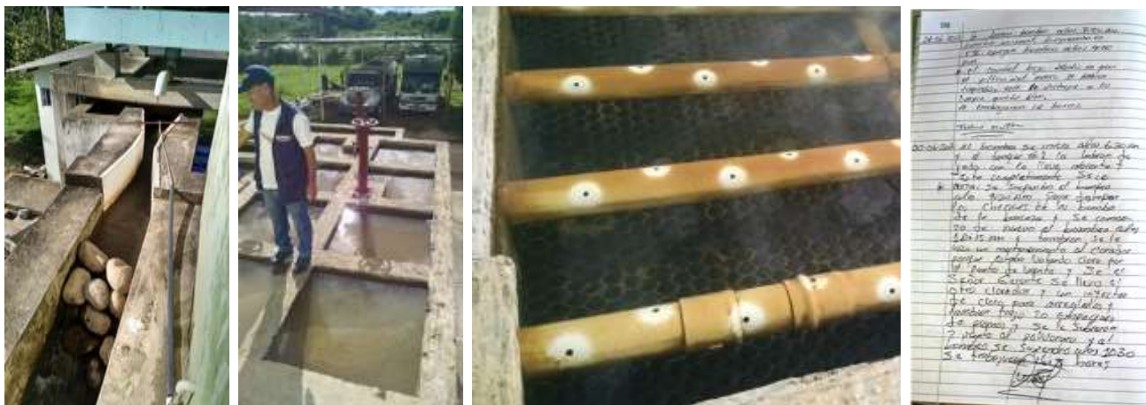
Imágenes 7 a 14: Arriba se observa la bocatoma flotante, tanque desarenador y macromedidor a la entrada de la PTAP. Abajo se presentan las instalaciones de la PTAP y la bitácora que se lleva en el lugar.
