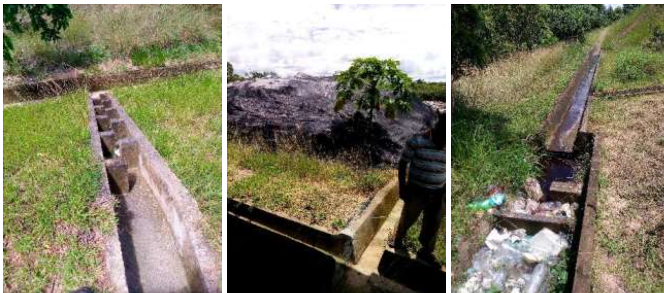
Imágenes 63 a 67: En las imágenes superiores se observa la red de canales recubiertos en concreto, mediante los cuales se manejan las aguas lluvias en la zona adyacente a las celdas; y el punto de descarga de las mismas en el sector suroriental de las celdas, sobre una canal en tierra que sale del predio. Nótese la acumulación de residuos plásticos en dicho punto. Abajo se presenta el ducto procedente de la celda No. 3, descargando agua de color oscuro y olor característico de agua residual con alto contenido orgánico (lixiviado), sobre la canal perimetral oriental de la celda No. 3.
