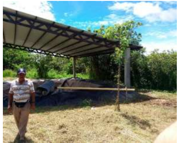
Imágenes 57 a 62: En las imágenes superiores se observa la celda 3 (en uso), dotada de geomembrana de fondo en buen estado, y los canales de recolección y conducción de lixiviado a través de filtros en piedra. Abajo se ilustra el pondaje de almacenamiento de lixiviado, dotado de cubierta y geomembrana; así como el ducto a través del cual se bombea el agua residual para ser vertida en el suelo adyacente al pondaje, donde se notorio un proceso de socavación asociada a dicha actividad.
