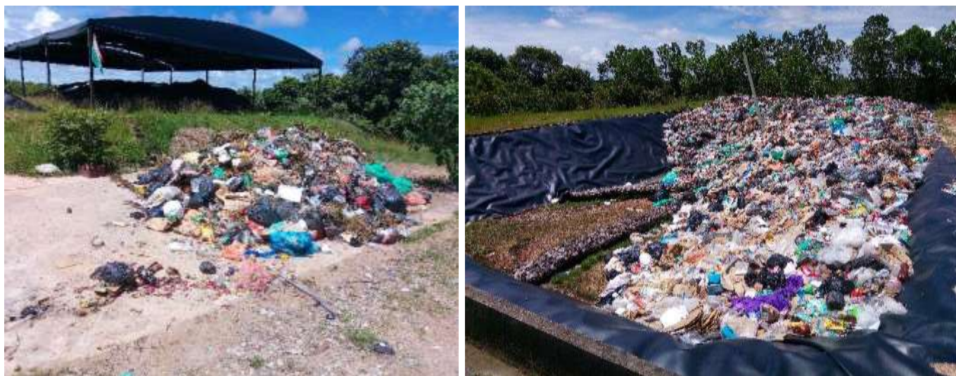
Imágenes 51 a 54: En su orden, se presenta la plataforma de descarga de residuos del Relleno Sanitario El Totumo, la celda No. 3 (actualmente en operación), la celda No. 2 (con cubierta de polisombra) y la celda No. 1 (con polisombra y tejado).
