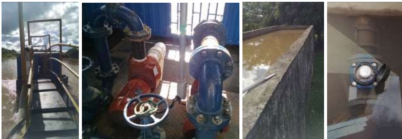
Imágenes 7 a 14: Arriba se observa la bocatoma flotante, tanque desarenador y macromedidor a la entrada de la PTAP. Abajo se presentan las instalaciones de la PTAP y la bitácora que se lleva en el lugar.
