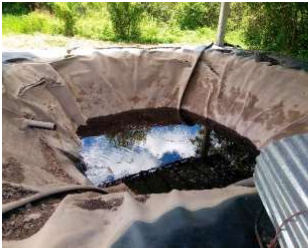
Imágenes 57 a 62: En las imágenes superiores se observa la celda 3 (en uso), dotada de geomembrana de fondo en buen estado, y los canales de recolección y conducción de lixiviado a través de filtros en piedra. Abajo se ilustra el pondaje de almacenamiento de lixiviado, dotado de cubierta y geomembrana; así como el ducto a través del cual se bombea el agua residual para ser vertida en el suelo adyacente al pondaje, donde se notorio un proceso de socavación asociada a dicha actividad.
