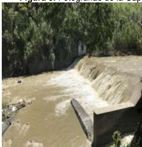
a. Captación en río Palo
