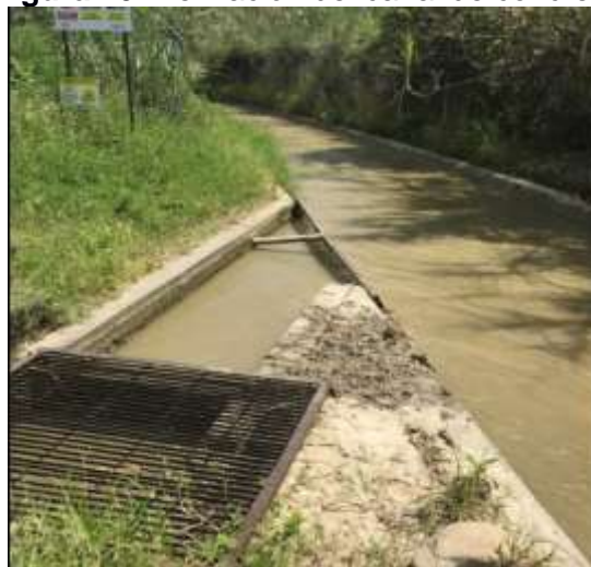
Figura 10. Derivación del canal de concreto
