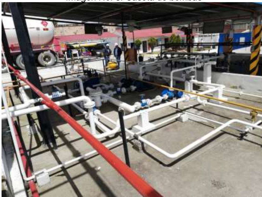
Imagen No. 8. Caseta de bombas
