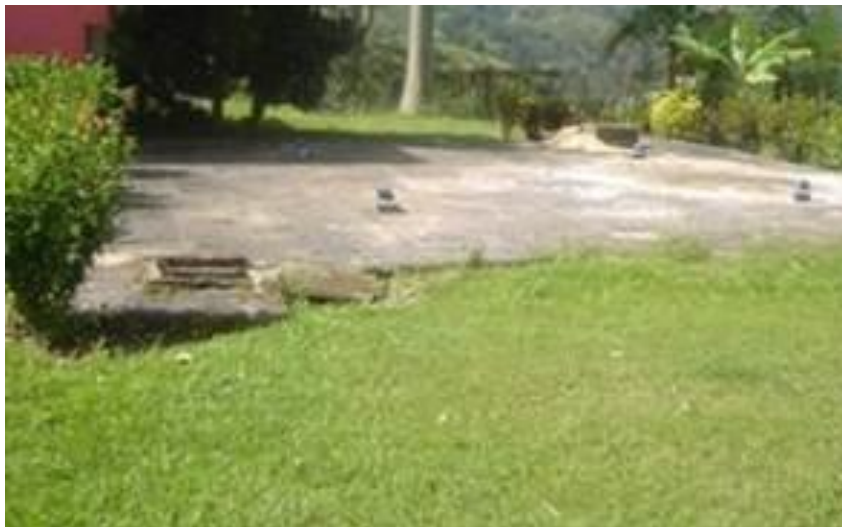
Imagen 15. Tanque de almacenamiento
