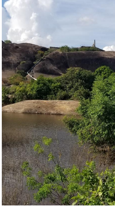
Tubería de entrada a la planta de tratamiento Fuente: Registro fotográfico SSPD – visita octubre de 2018
