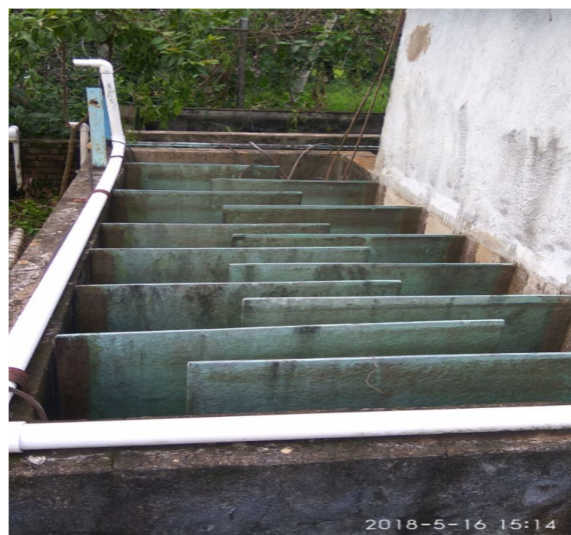
Imagen 8 Modulo Coagulación. .
