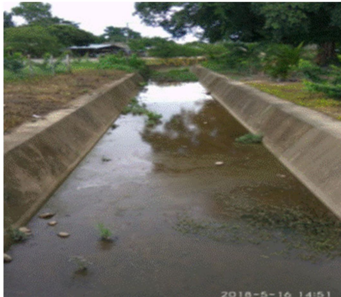
Imagen 13 Canal de Aguas Lluvias
