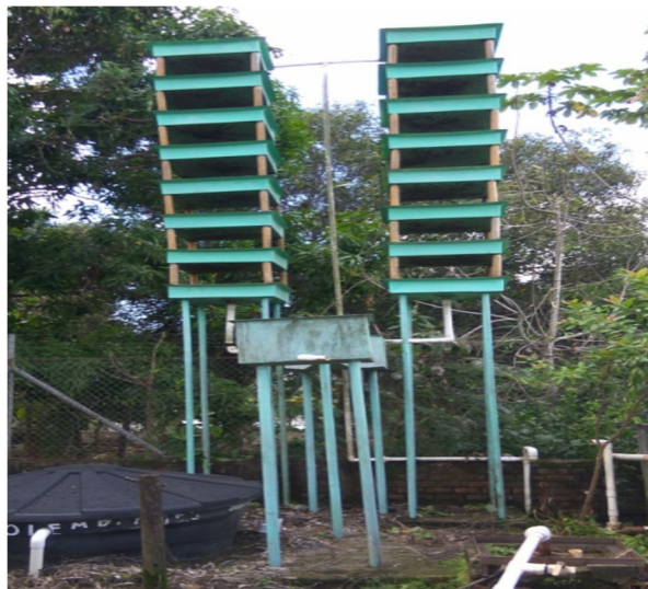
Imagen 7 Torres de Aireación
