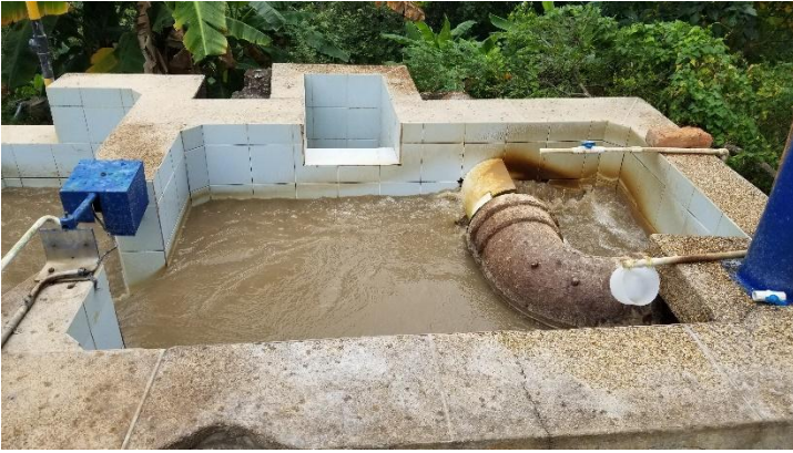
Cámara de entrada
