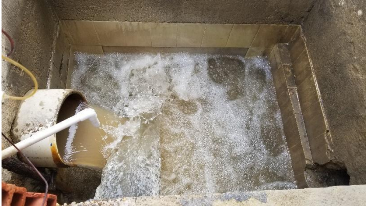
Cámara de entrada
