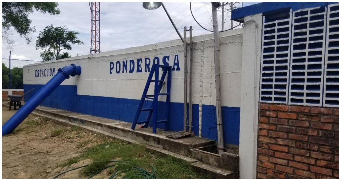
Imagen 8. Estación de bombeo Ponderosa
