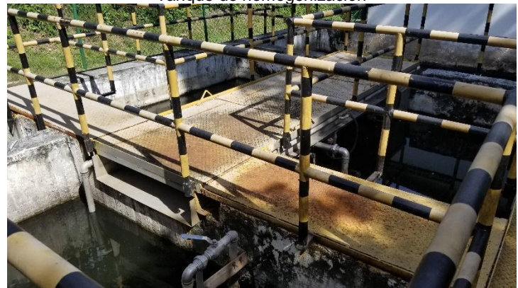
Tanque de aireación
