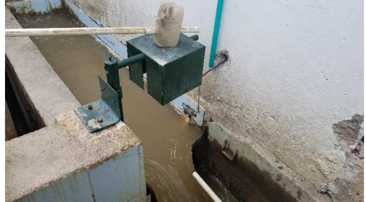
Aplicación de coagulante y medición de caudal de entrada
