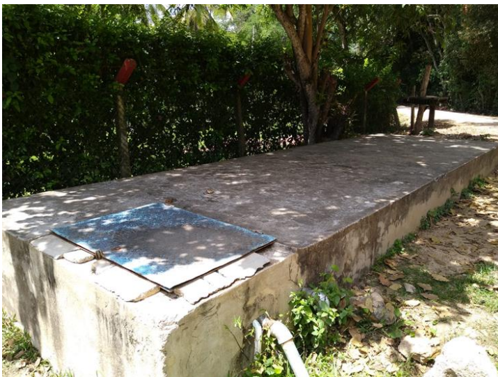
Tanque San José
