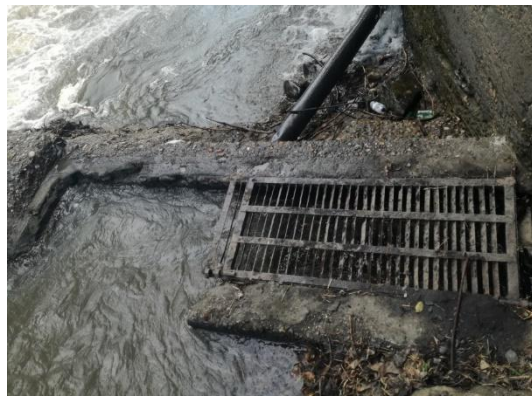
Imagen 13. Estructura de captación
