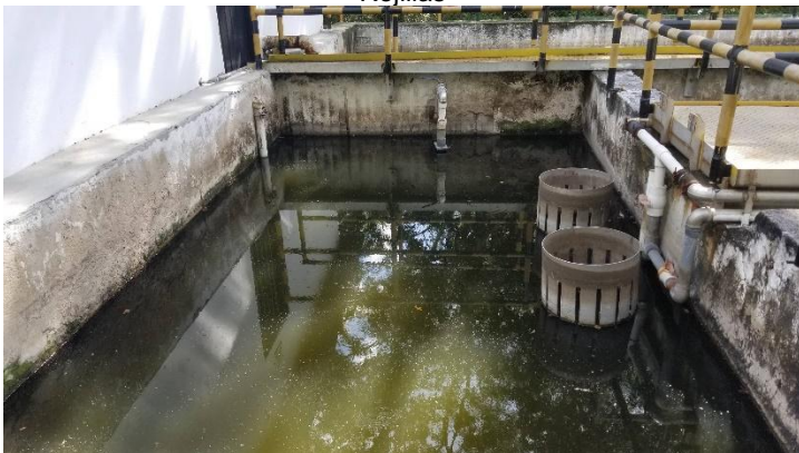
Tanque de aireación
