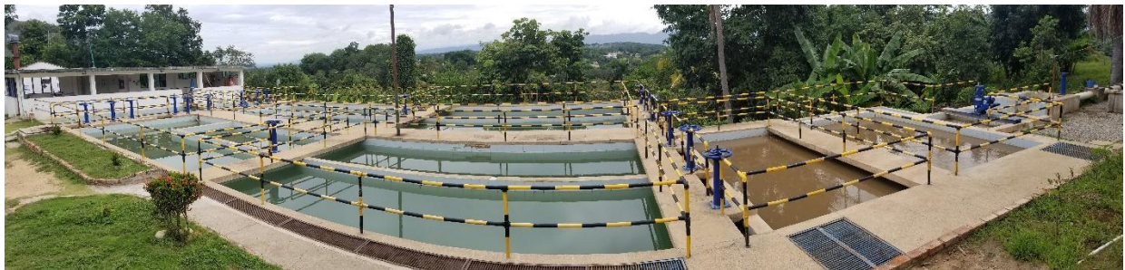
Vista general de la planta
