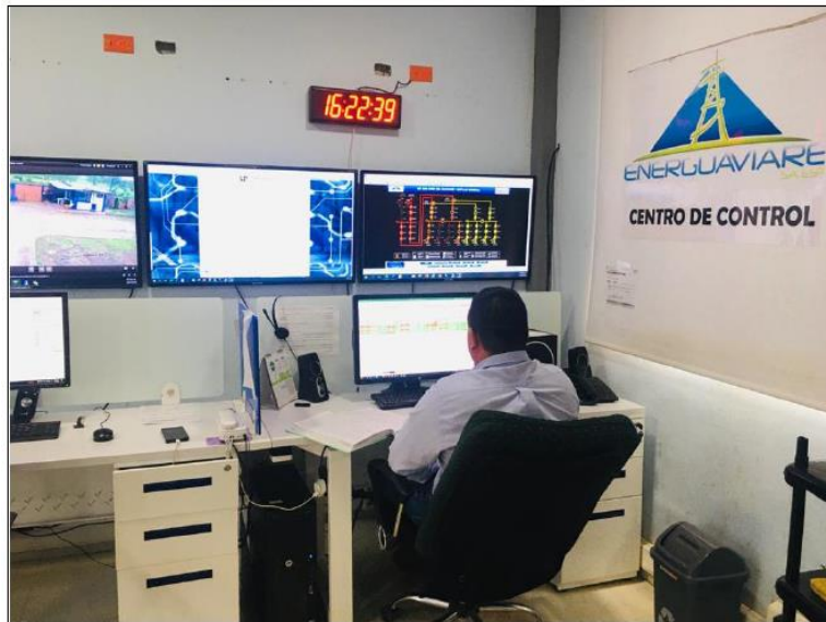
Ilustración 4 Centro de control - Energuaviare
