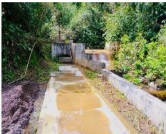
Bocatoma quebrada la Olavica
