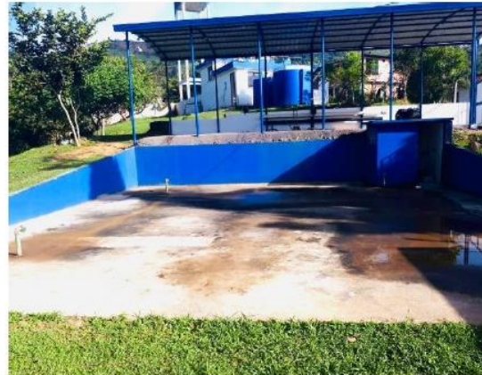
Tanque de distribución No. 2
