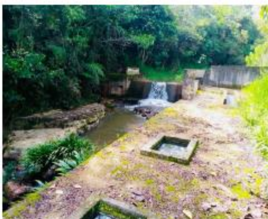
Bocatoma quebrada la Mochilera
