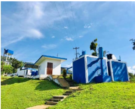
Vista filtros y tanque aereo
