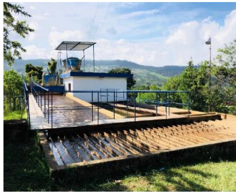
Floculador y sedimentador
