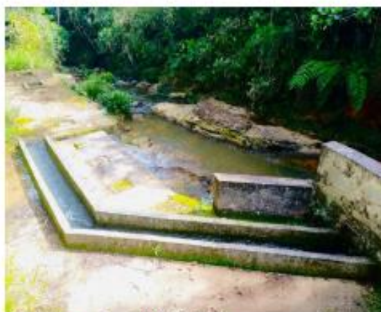
Bocatoma quebrada la Mochilera
