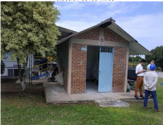
Depósito de cal y químicos para procesos en planta
