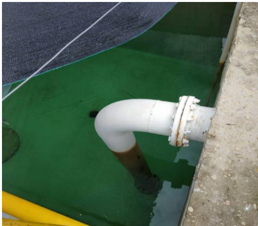
Protección de los filtros
