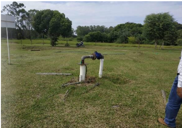
Pozo 1 profundidad 80 m
