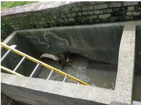
Llegada a la planta, se realiza medición de caudal con micro molinete
