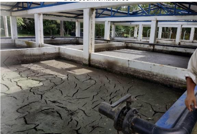
Piscinas de desecación de lodos
