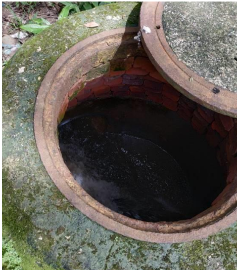
Pozo de medición agua arriba de descarga
