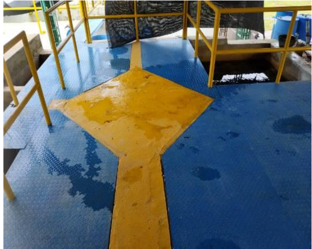
Tanque de cloración
