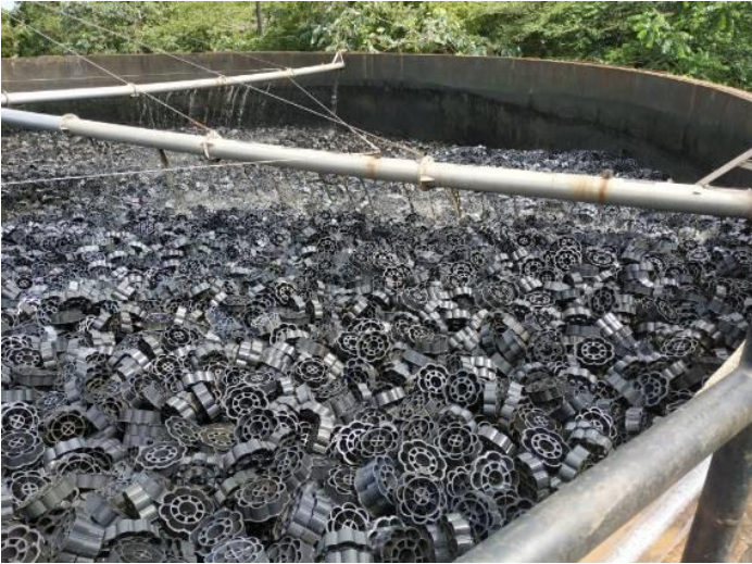
Filtro Percolador – material octogonal de plástico
