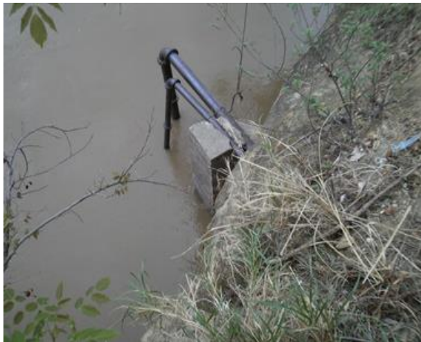
Captación de caseta 1
