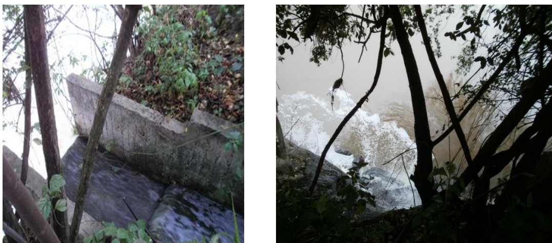
Imagen 30. Punto de vertimiento laguna de oxidación Alfonso López
