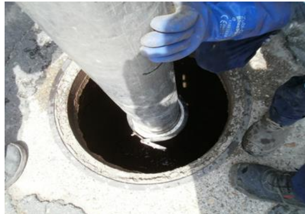
Mantenimiento pozos de inspección
