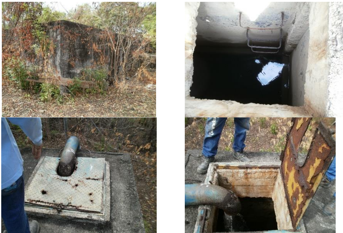
Imagen 22. Estado Tanque de almacenamiento 3
