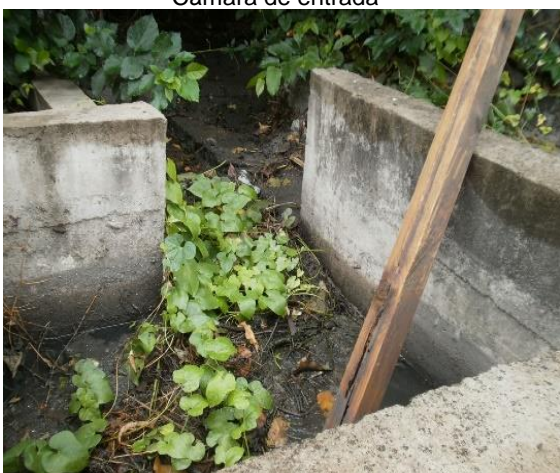
Canal de entrada
