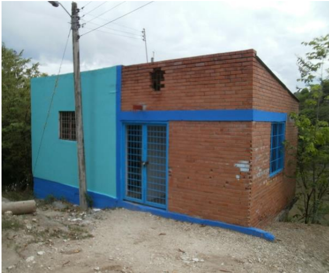
Estación de bombeo caseta 2
