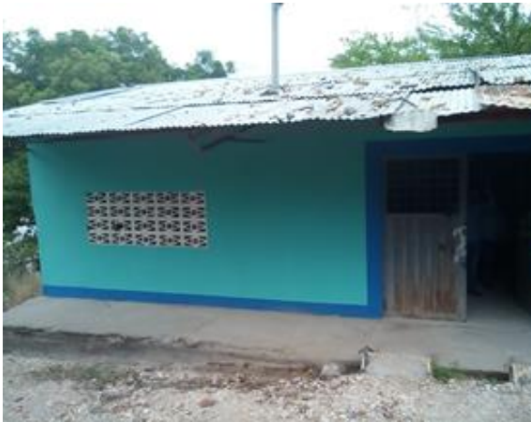
Estación de bombeo caseta 1
