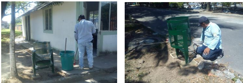
Imagen 43. Instalación de cestas por el prestador
