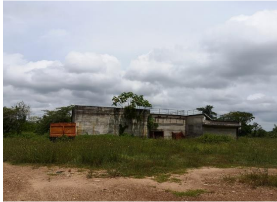
Imagen 12. PTAR fuera de uso
