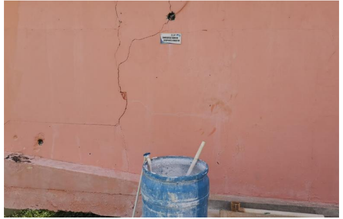
Dosificación de cloro
