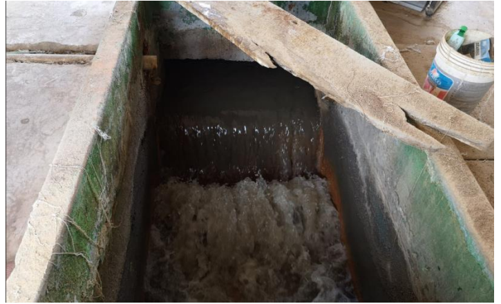
Canal de entrada
