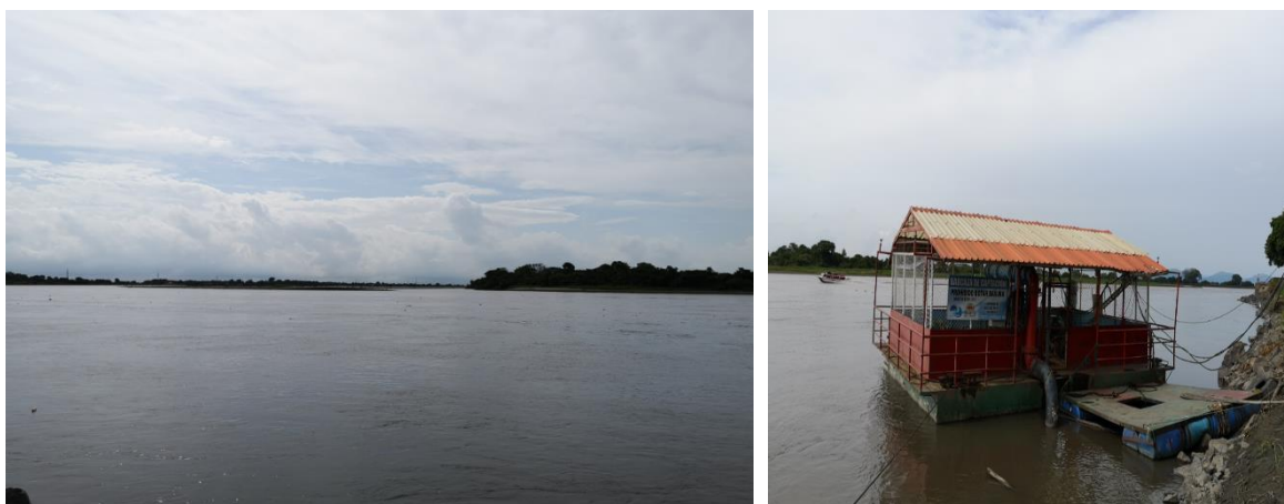
Imagen 3. Captación Barcaza flotante Río Cesar - Magdalena
