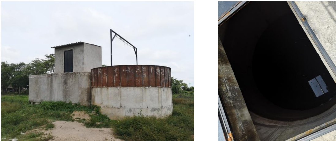
Imagen 13. Estación de bombeo La Esmeralda
