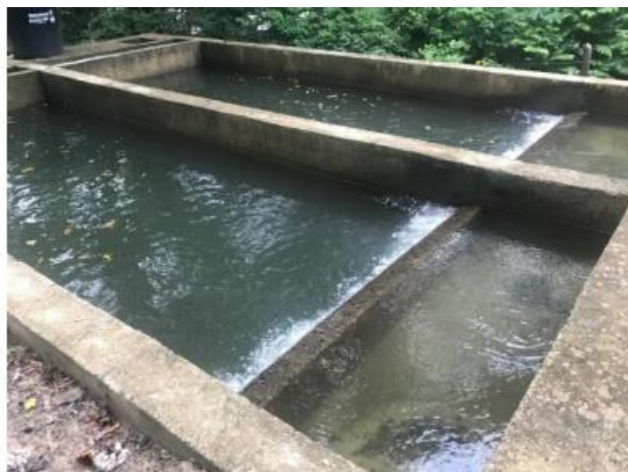
Imagen 11. Desarenado sistema Mingueo
