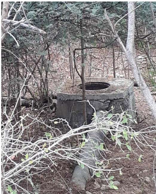
Pozo de ingreso
