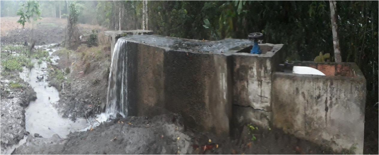
Imagen 9. Desarenador de Río Ancho
