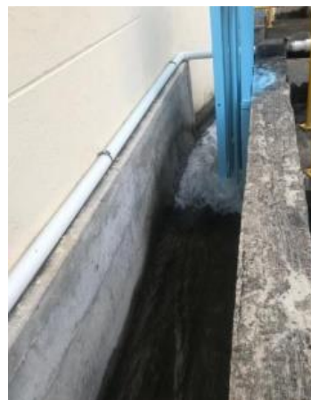
Canal de ingreso
