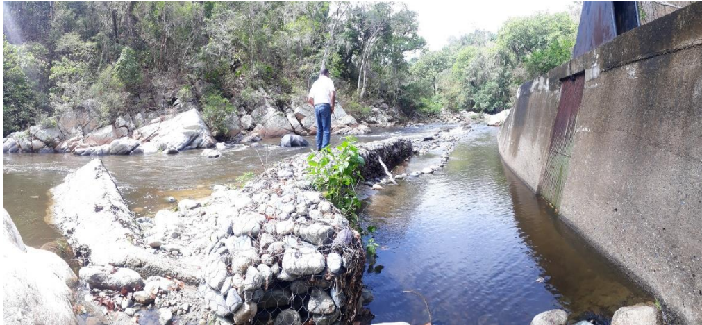
Estructura dique artesanal contiguo a la bocatoma
