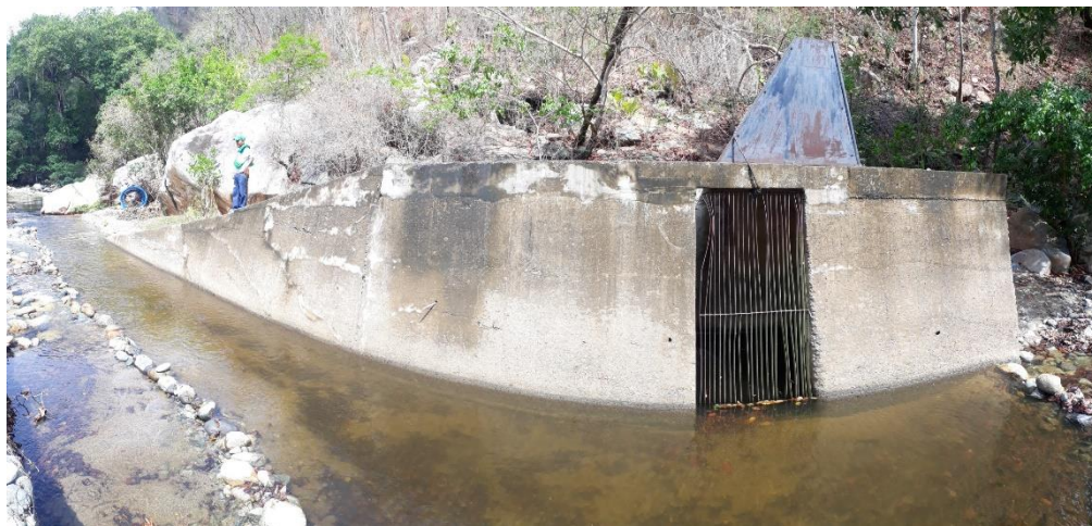
Bocatoma lateral / Cámara de reparto
