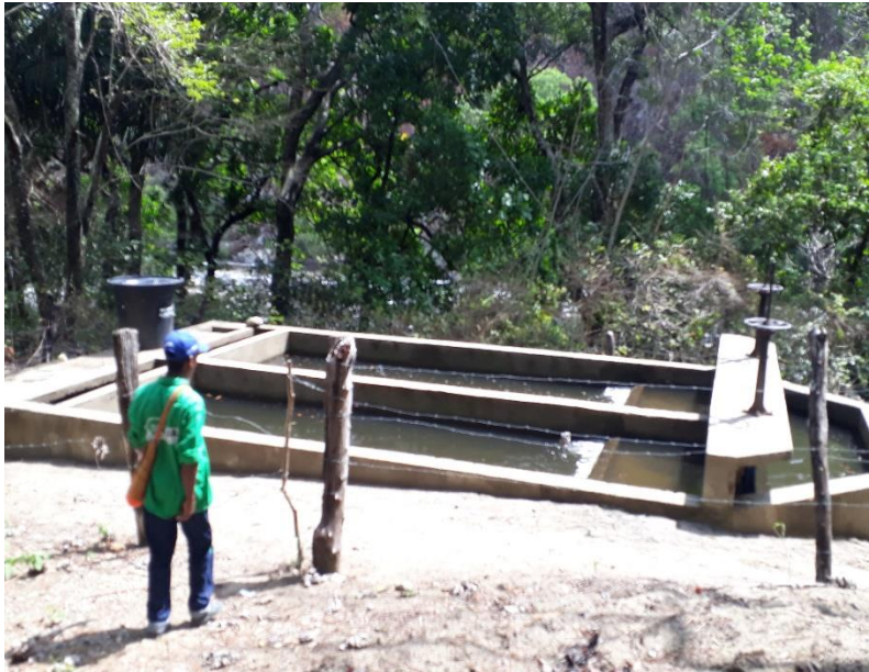
Imagen 10. Desarenador de Río Jerez
