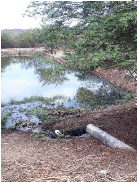
Ducto de paso de una laguna a otra
