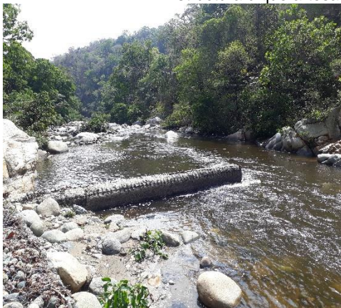
Estructura de dique antiguo / fuera de operación
