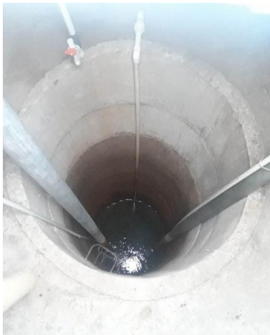
Pozo, diámetro 2 m
