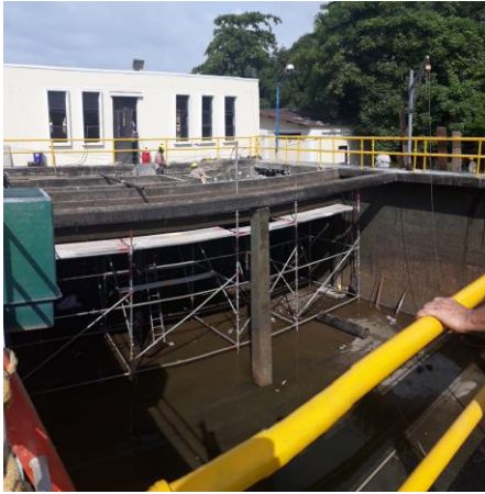
Obras en ejecución
