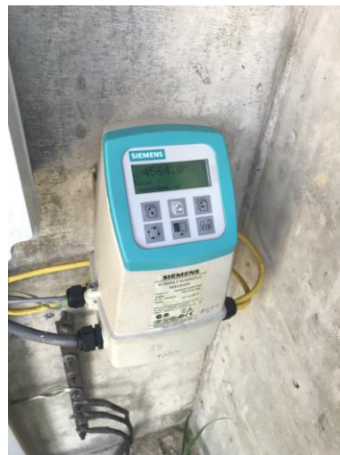
Imagen 8. Macromedidores a la salida de la captación “Dolores”
