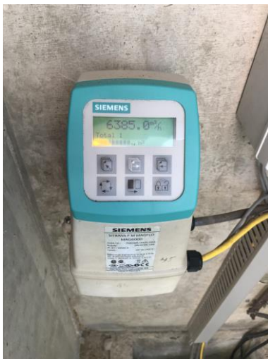
Imagen 8. Macromedidores a la salida de la captación “Dolores”
