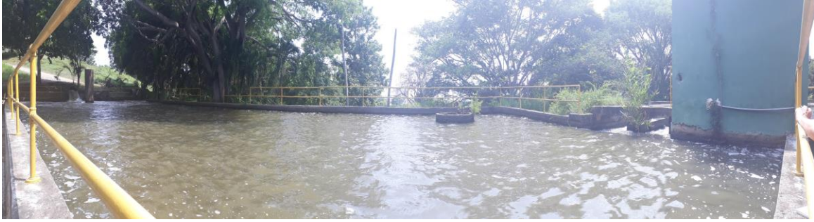
Imagen 19. Ingreso a PTAP - Tanques de mezcla
