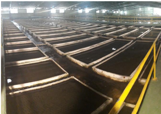
Sedimentadores de alta tasa, tipo colmena
