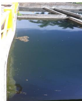
Presencia de algas en sedimentadores
