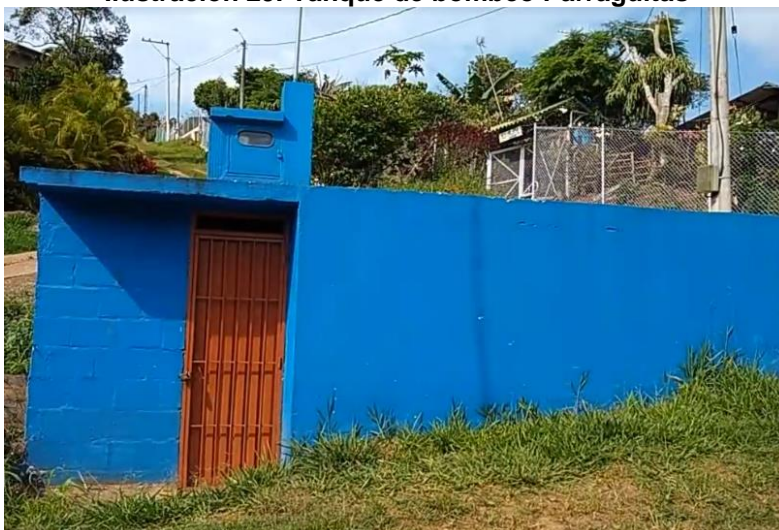
Ilustración 29. Tanque de bombeo Parraguitas
