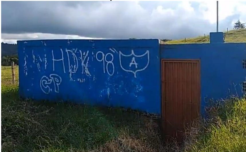
Ilustración 32. Tanque de rebombero San Isidro
