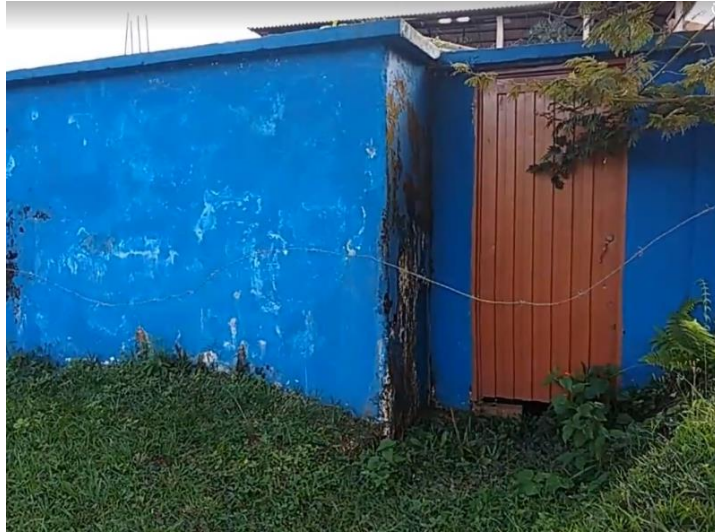
Ilustración 31. Rebombero El Retiro
