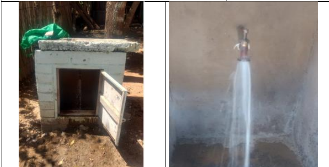
Fuente: Registro fotográfico de la visita, realizada los días 18, 19 y 20 de septiembre de 2019.
