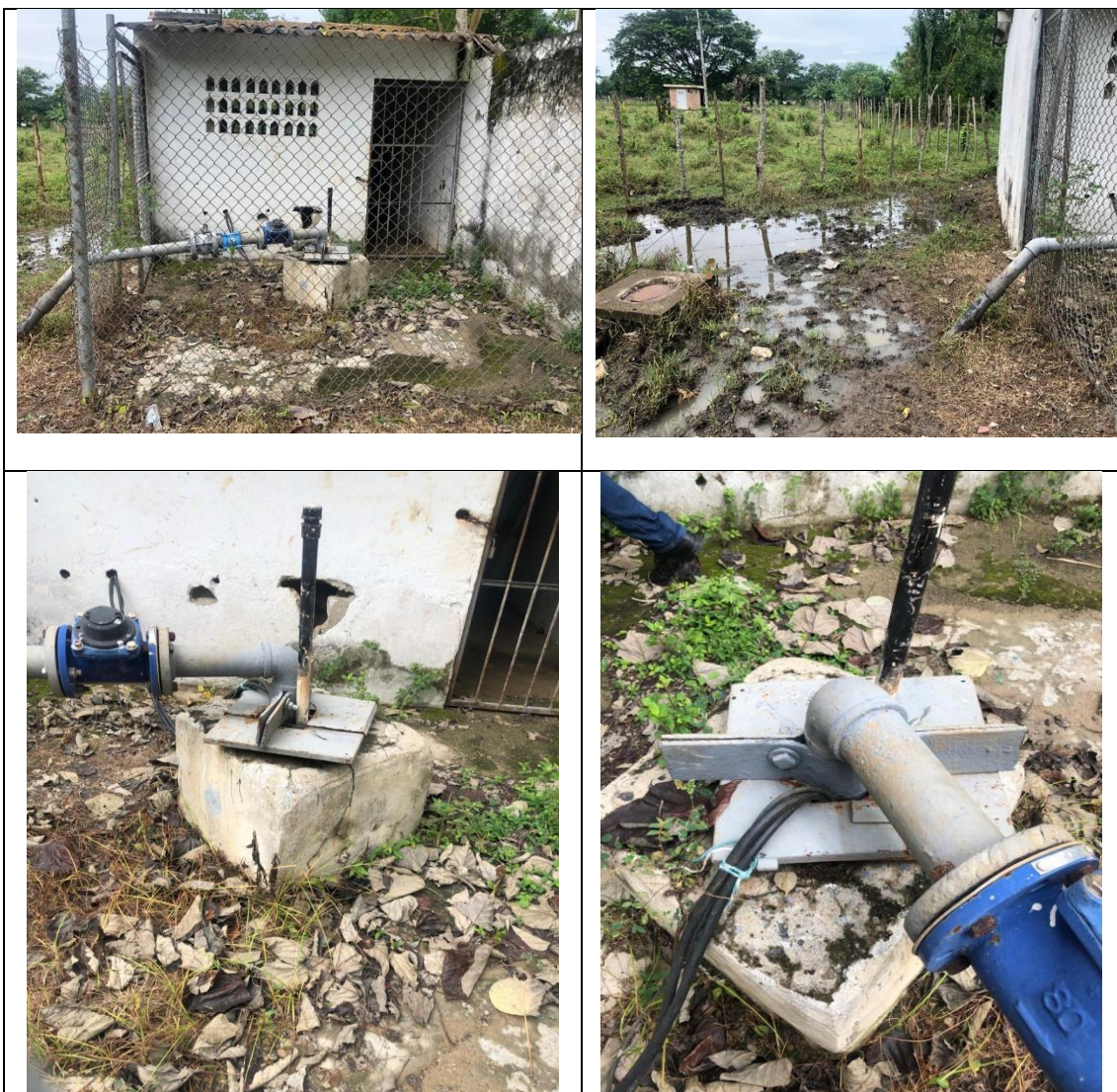
Fuente: Registro fotográfico de la visita, realizada los días 18, 19 y 20 de septiembre de 2019.
