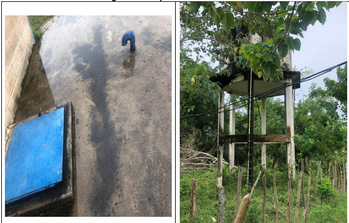
Imagen 13. Tanques de almacenamiento
