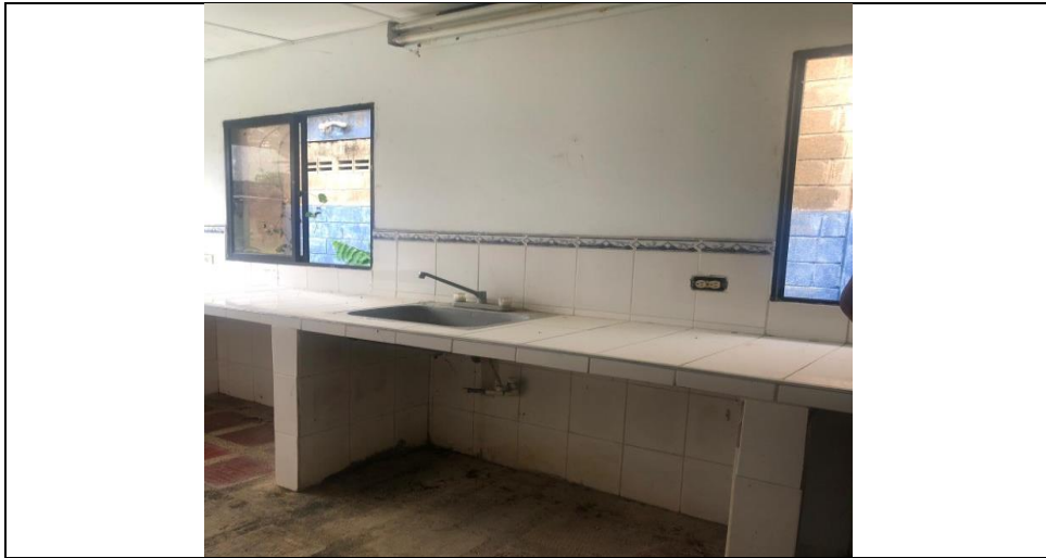
Imagen 12. Espacio adecuado para laboratorio
