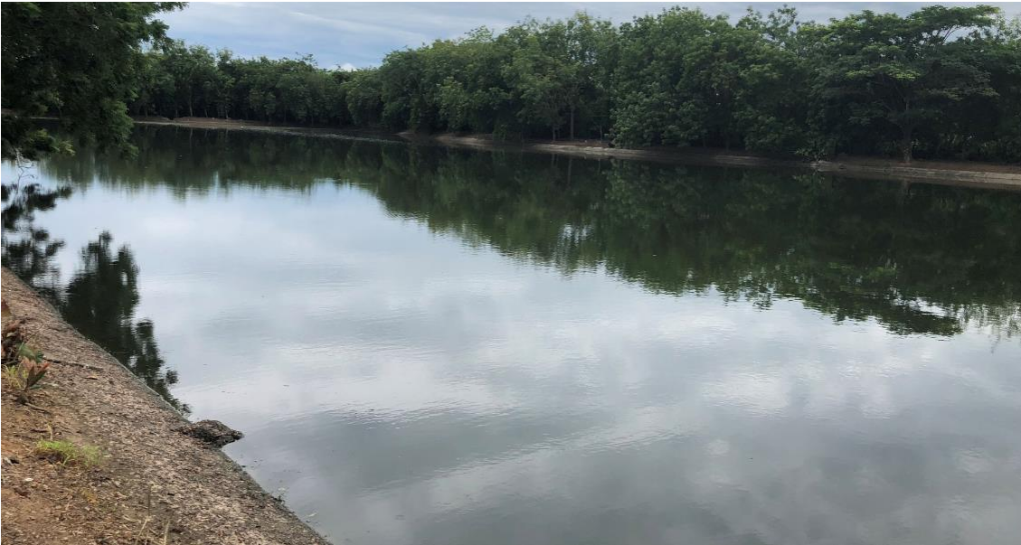
Laguna de Oxidación
