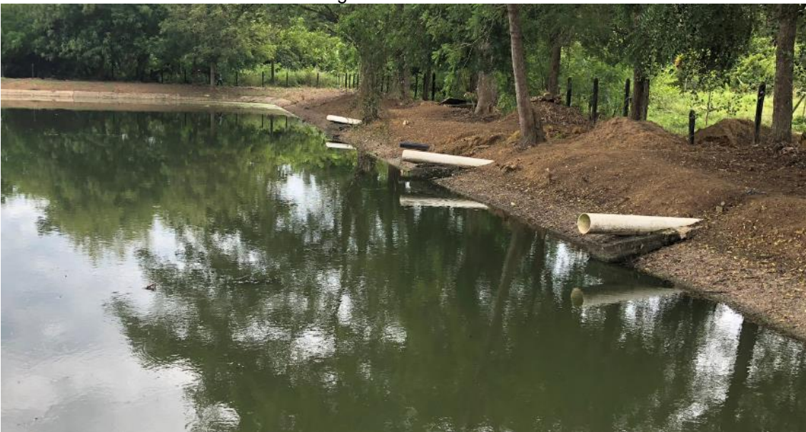
Descargas de ARD a la laguna.
