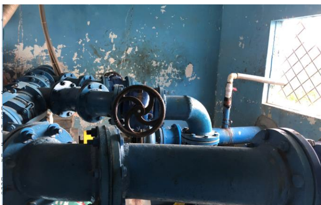
Caseta de Bombeo
