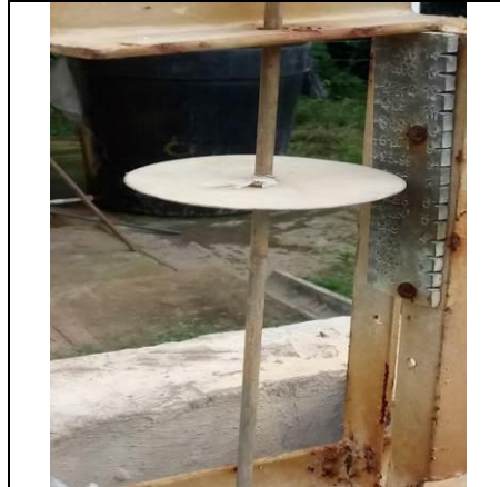
Fotografía No. 4 Medidor de Caudal ingreso PTAP
