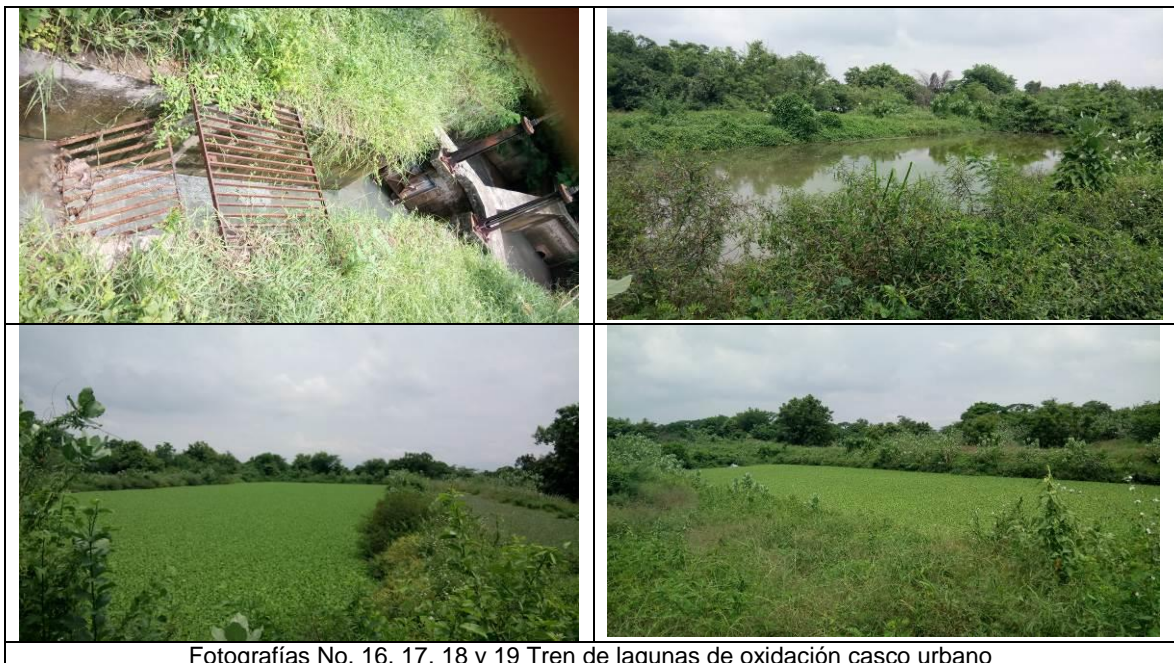
Fotografías No. 16, 17, 18 y 19 Tren de lagunas de oxidación casco urbano
