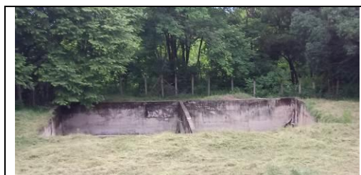
Fotografía 9 Estructura de tanque de almacenamiento sin terminar
