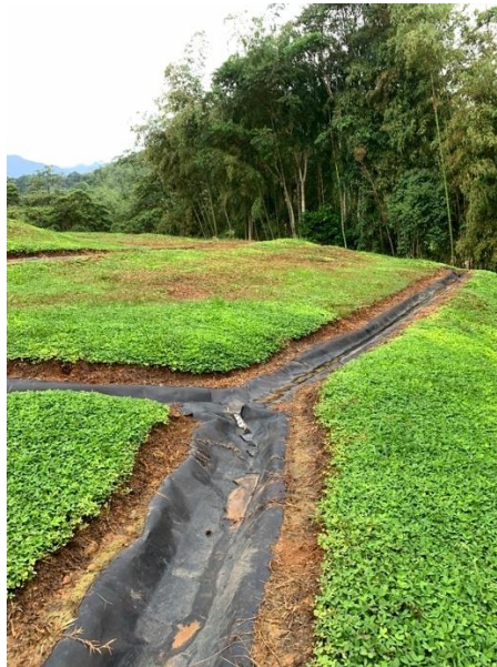
Ilustración 25. Canales de agua lluvia zona en proceso de clausura
