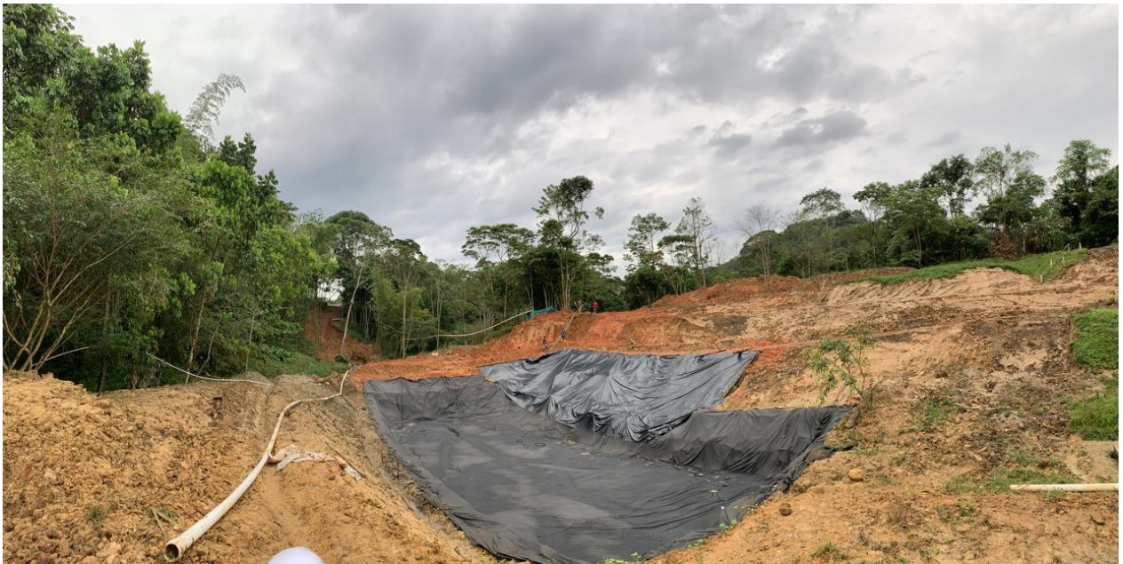
Ilustración 22. Nueva piscina en construcción
