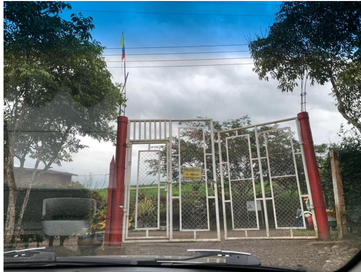
Ilustración 4. Ingreso al relleno
