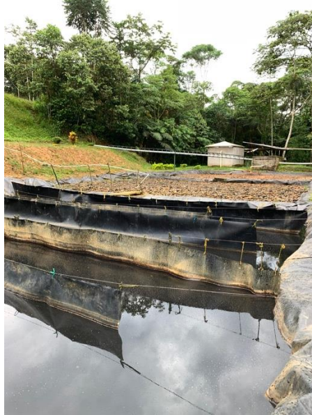
Ilustración 21. Piscina de lixiviados
