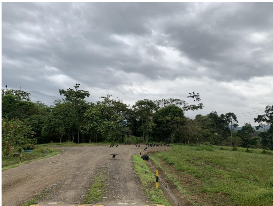
Ilustración 26. Canales perimetrales en concreto
