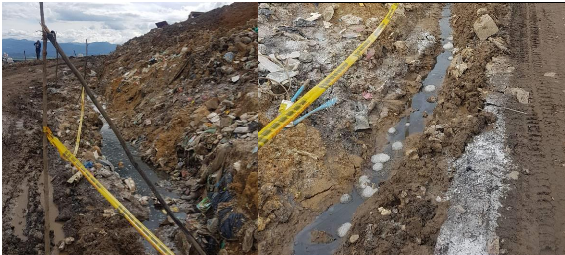
Ilustración 21. Lixiviados en frente de trabajo
