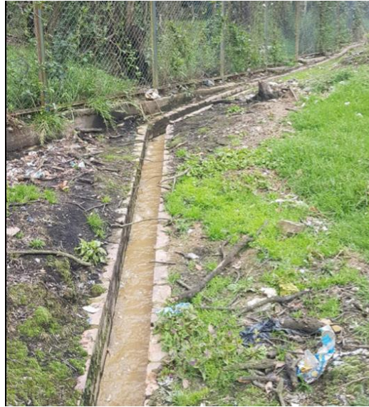
Ilustración 20. Canales de agua lluvia
