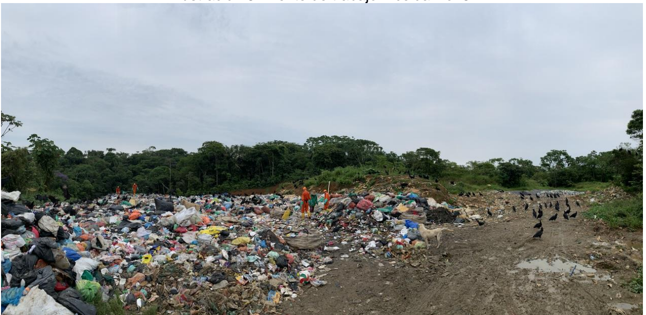
Ilustración 8. Frente de trabajo – celda No. 8
