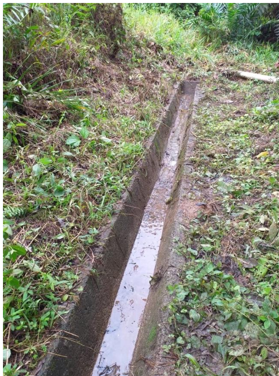
Ilustración 15. Canales de agua lluvia
