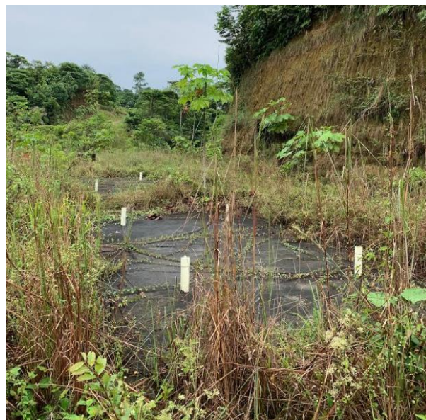
Ilustración 17. Sistema de tratamiento de lixiviados
