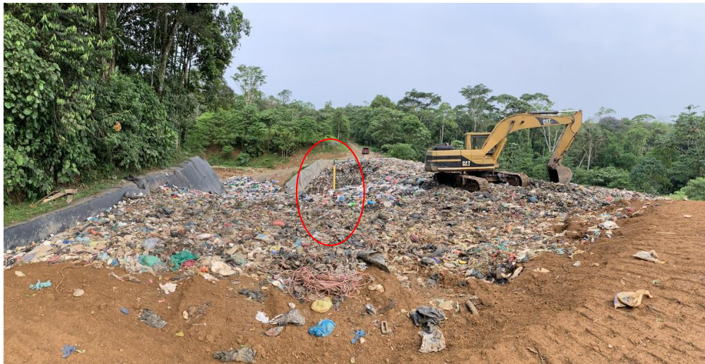
Ilustración 14. Chimenea celda No. 5
