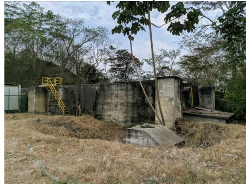
b) Tanque de 6.000 m 3 .
