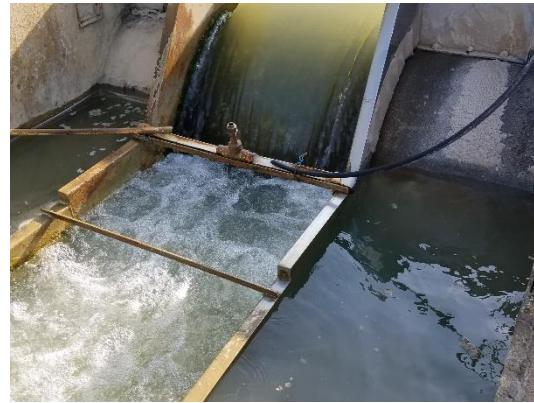
b) Dosificación de coagulante.
