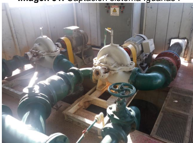
Imagen 31. Captación sistema Iguanas I
