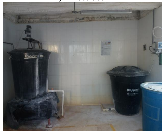
h) Dosificación de coagulante.
