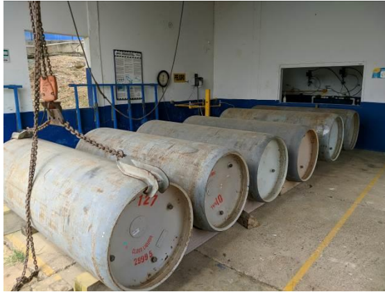
e) Tanques de cloro gaseoso.
