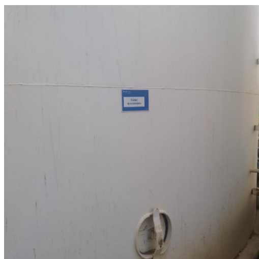
d) Unidad de tratamiento.
