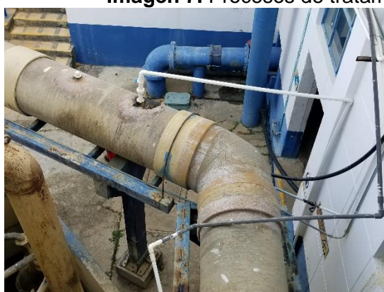
a) Dosificación de coagulante.
