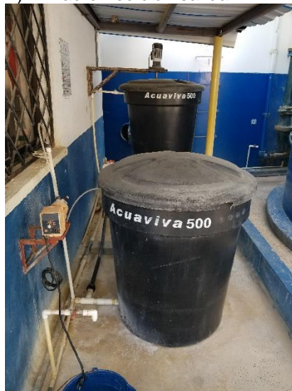
h) Dosificación de coagulante.
