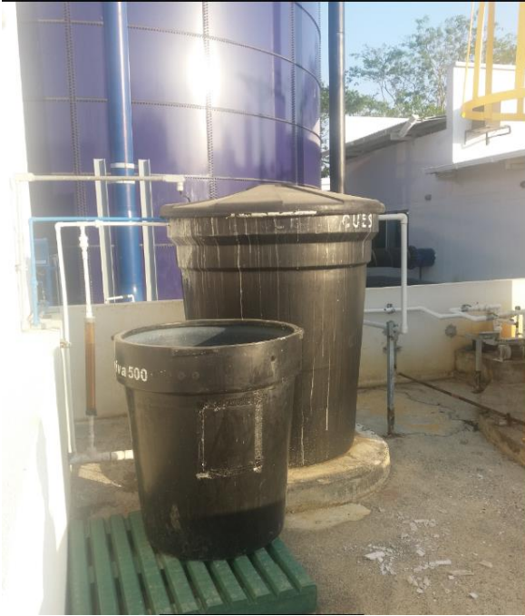
e) Dosificación de coagulante.
