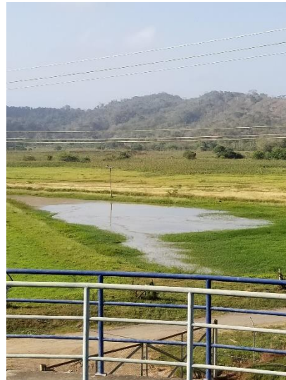
h) Lagunas de lodos.
