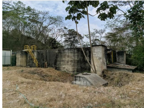
b) Tanque de 6.000 m 3 .
