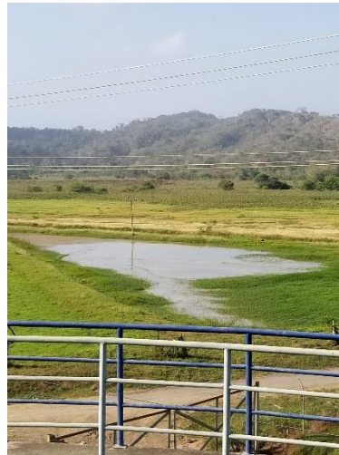
f) Lagunas de lodos.
