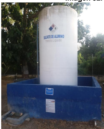
a) Tanque de contención de sulfato de aluminio.
