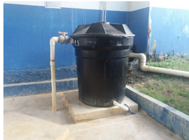
h) Dosificación de coagulante.
