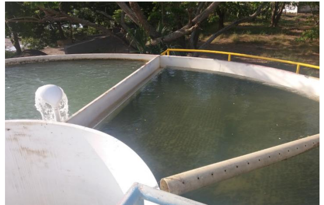
b) Sedimentador.
