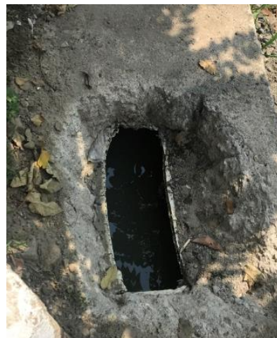
Reparación manual de la red de alcantarillado
