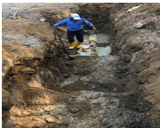
Obras de cambio tubería de alcantarillado
