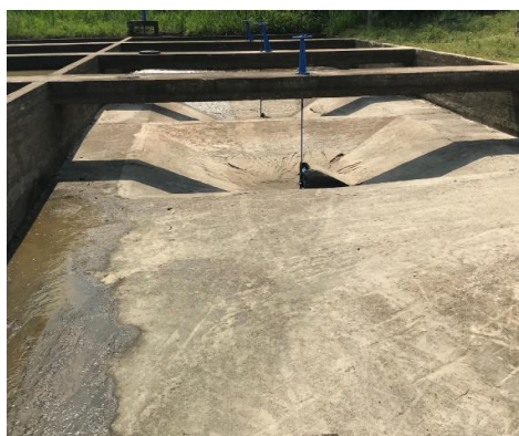
Desarenadores en mantenimiento
