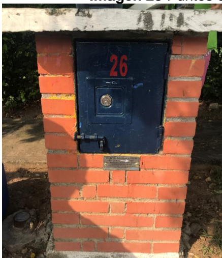
Punto debidamente sellado.
