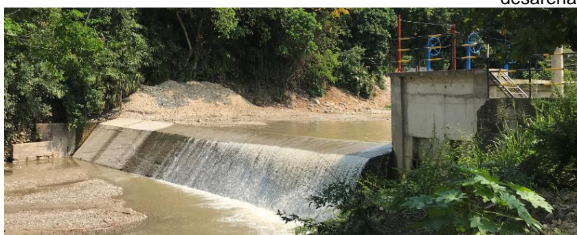
Estructura de Captación
