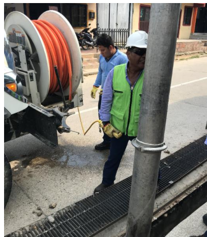
Mantenimiento de Sumideros
