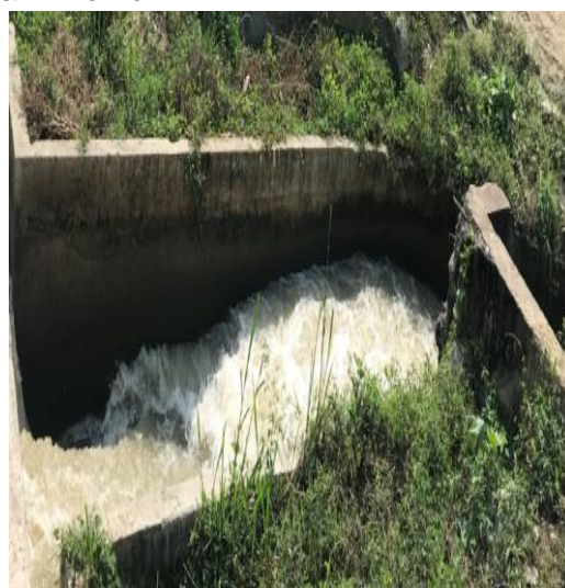
Canal de conducción al sistema de desarenación
