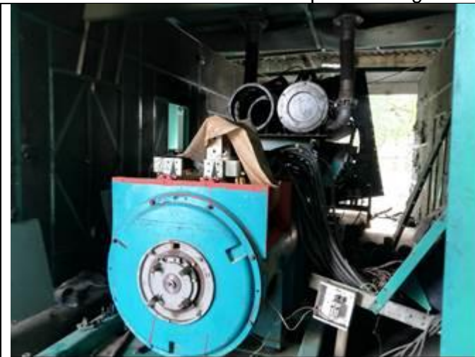
Planta No3 Grupo Electrónico CUMMINS QST – 50 de 1500 kW Cabecera Municipal de Acandí (Fuera de servicio)
