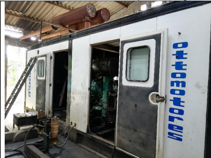
Planta No1 Grupo Electrónico CUMMINS QST – 30 de 1000 kW Cabecera Municipal de Acandí (Operativa)
