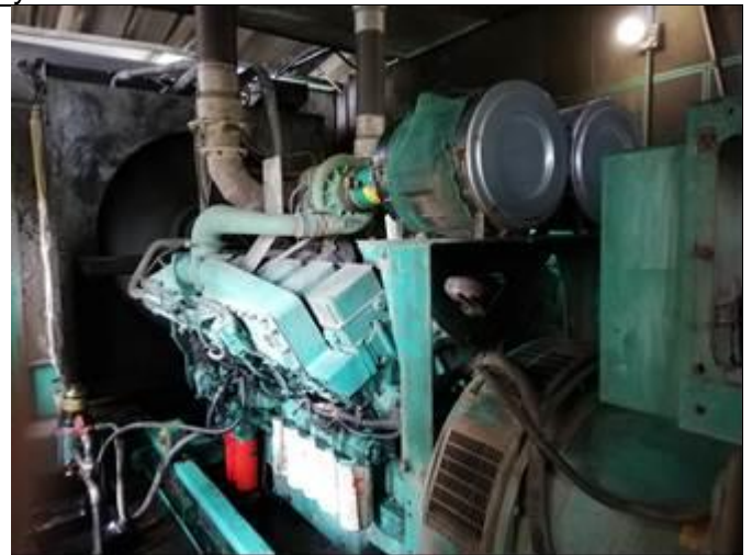
Planta No4 Grupo Electrónico CUMMINS QST – 50 de 1500 kW Cabecera Municipal de Acandí (Operativa)
