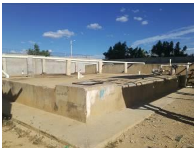
Imagen 16. Tanque de almacenamiento agua potable.
