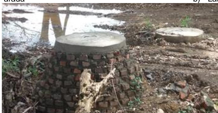
c) Pozo de inspección.
