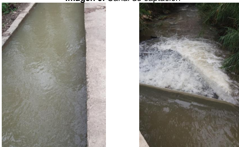
a) Canal de captación en concreto. b) Canal de excesos al río Táchira.
