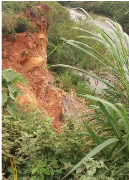
Imagen 11. Talud sobre la estructura de captación
