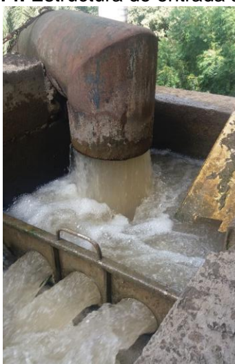
Imagen 14. Estructura de entrada a la PTAP
